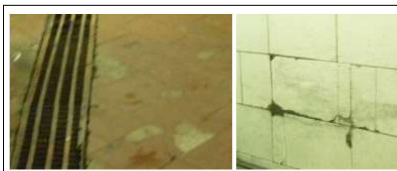
Figura 4.8. Paredes y pisos no lisos de la Cocina
