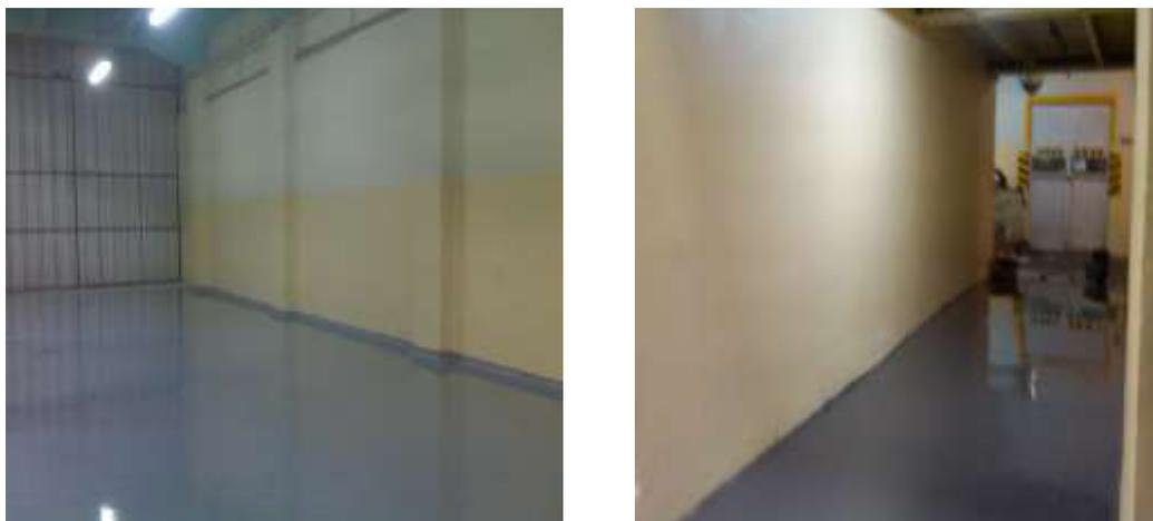
**FIGURA 2.13 DE IZQUIERDA A DERECHA: PISO EPÓXICO DEL ÁREA DE EMPAQUE PRIMARIO E INGRESO A LA BODEGA DE TRÁNSITO.**
