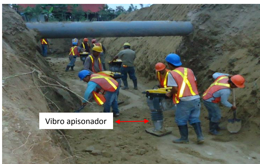
Figura 2.17. Uso de vibro apisonador en la compactación del replantillo
