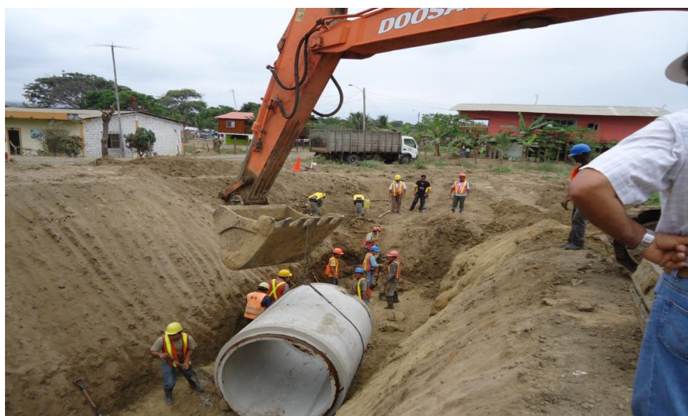
Figura 4.11 Colocación de una tubería.
