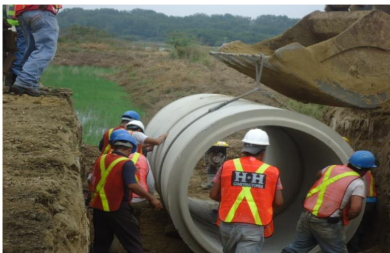
Figura 4.14 Unión de las tuberías
