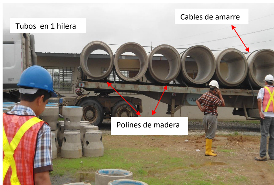
Figura 1.10 Transporte de tubos de hormigón armado
