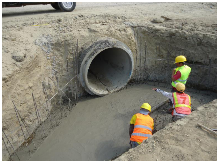
Figura 2.14 Fundición de losa de hormigón armado.
