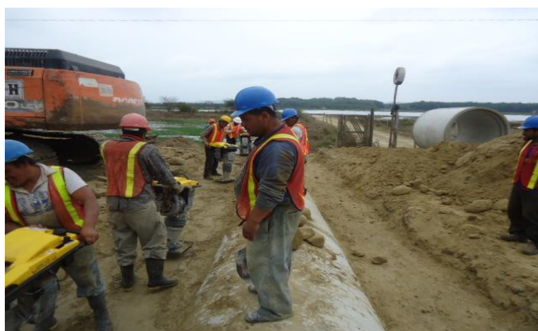
Figura 4.15 Relleno de las alcantarillas hasta la cota de lomo
