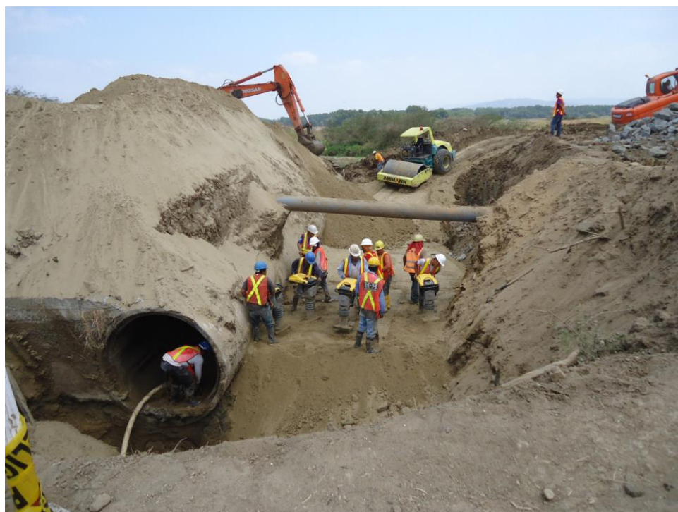
Figura 5.3 Limpieza manual de la alcantarilla.
