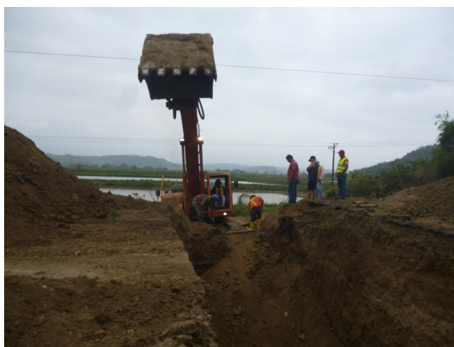
Figura 4.2 Excavación en el eje de la alcantarilla.
