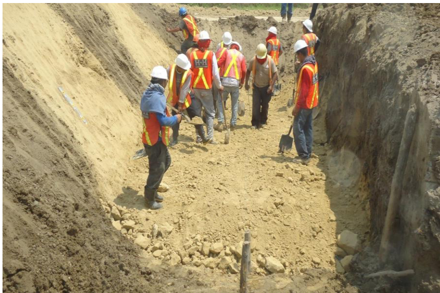
Figura4.10 Tendido de la capa de arena de 20 cm de espesor.
