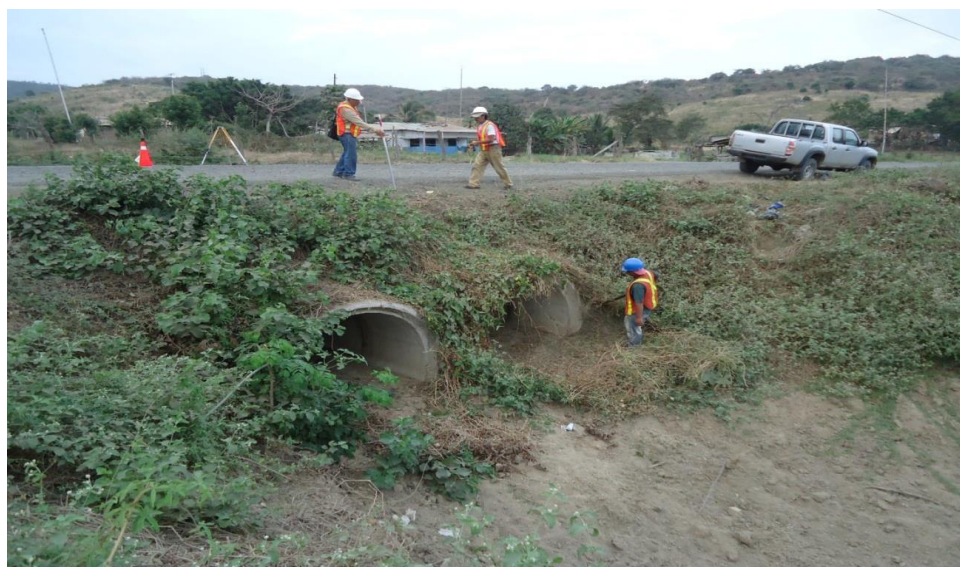
Figura5.1 Estado de alcantarillas después de la instalación.
