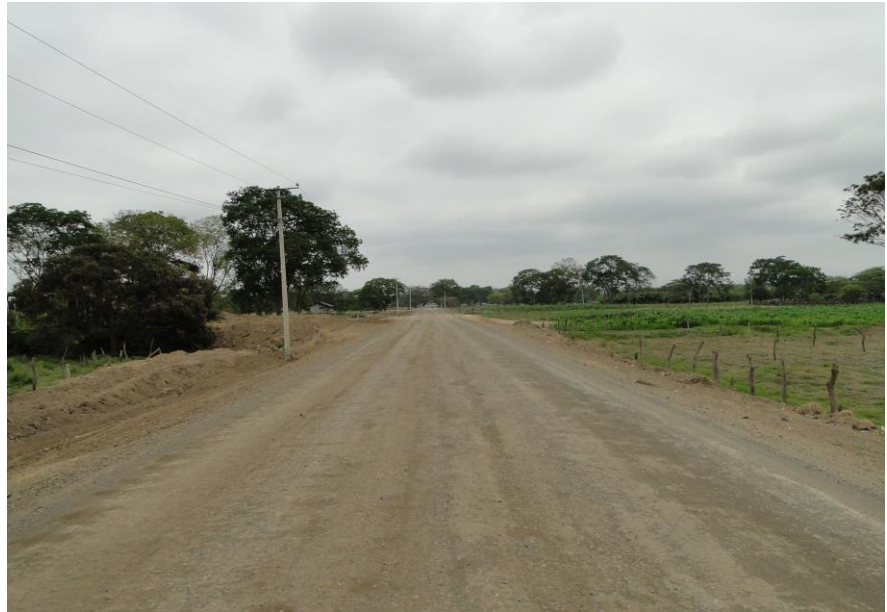
Figura 2.4 Terraplén de la vía Margarita–San Antonio–San Vicente
