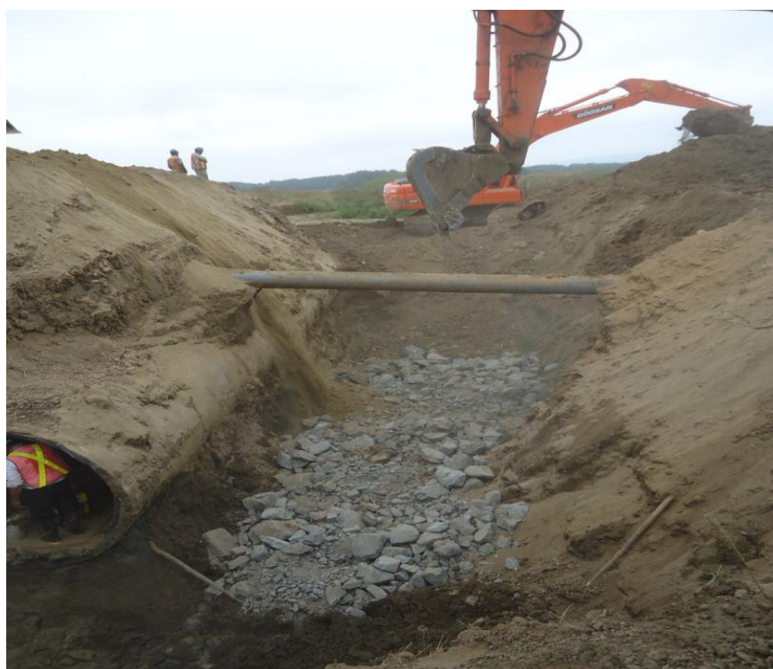
Figura 4.9 Colocación del replantillo de base clase 1B
