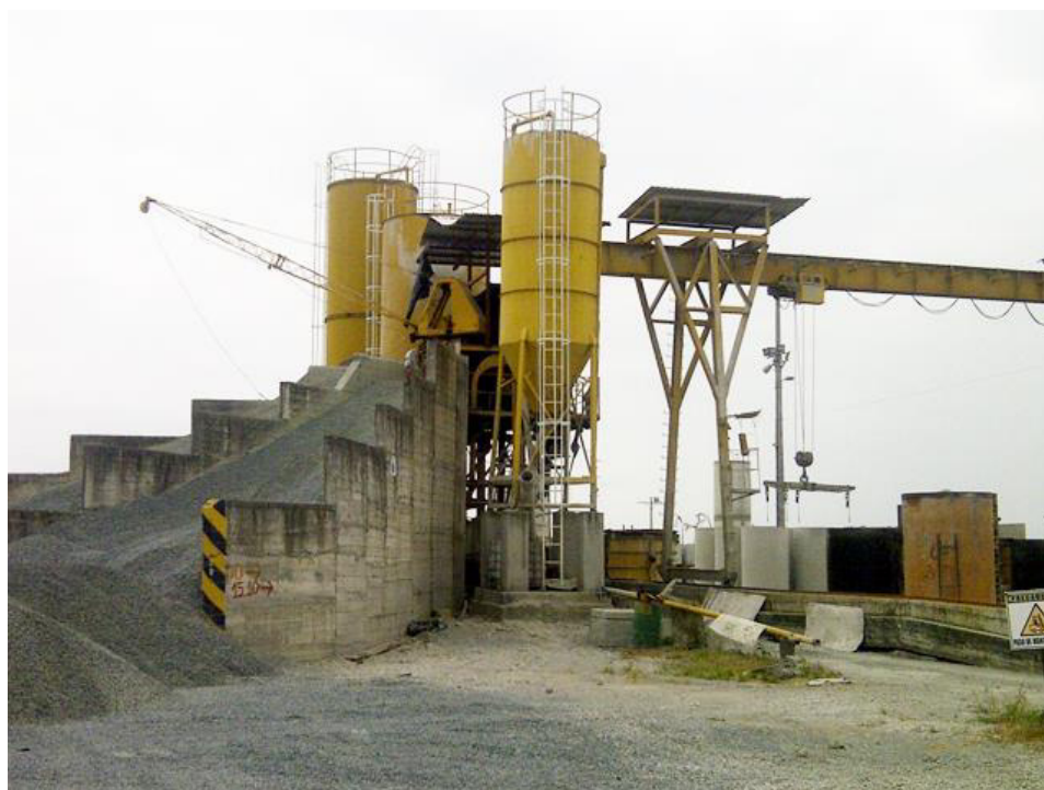
Figura 1.3 Maquinaria para la elaboración del hormigón de la tubería.
