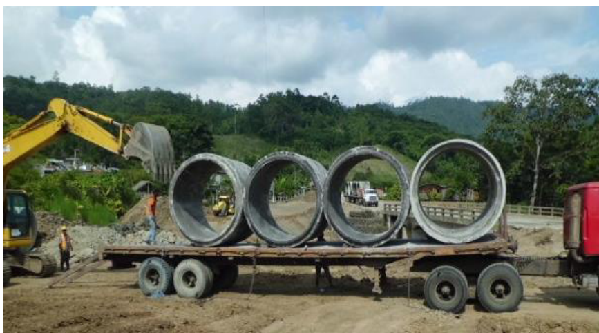
Figura 2.15 Maquinaria utilizada para el transporte de las tuberías
