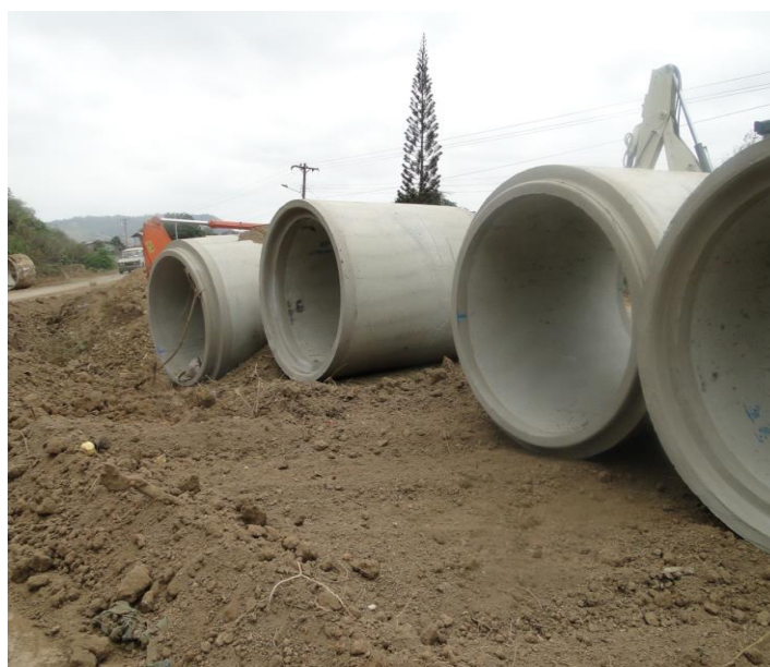
Figura 1.11 Zona de descarga de las tuberías de 60" en obra
