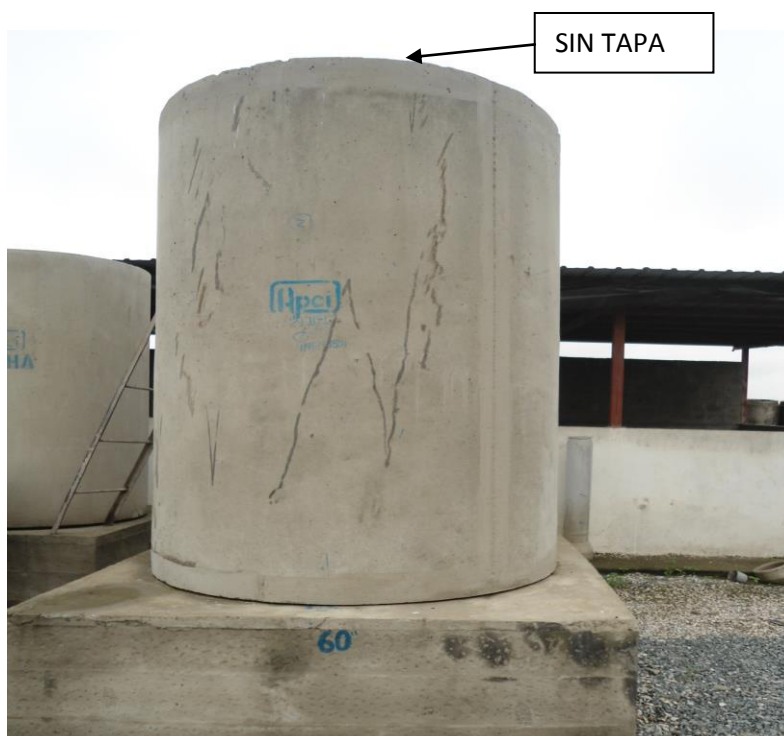
Figura 1.8 Ensayo de estanqueidad al tubo de 60"
