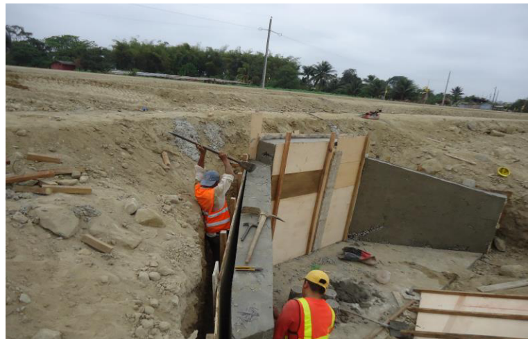
Figura.2.13 Muro de alas a la entrada de la alcantarilla
