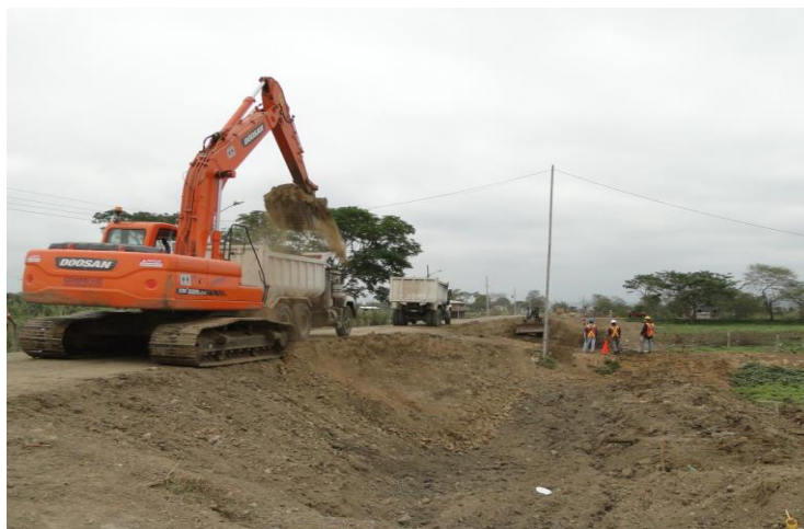
Figura 4.1 Maquinaria realizando desalojo de manera continua
