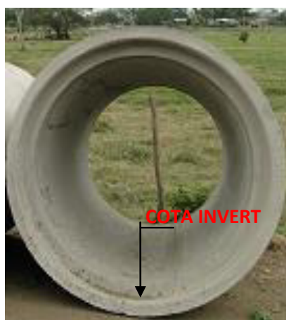
Figura 2.12 Cota invert de la tubería
