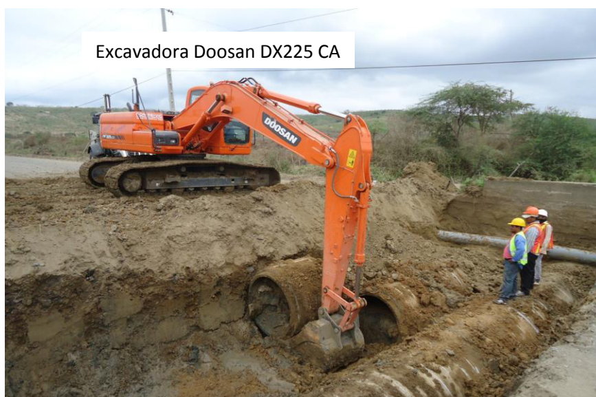
Figura 2.16 Maquinaria utilizada para instalación de las tuberías
