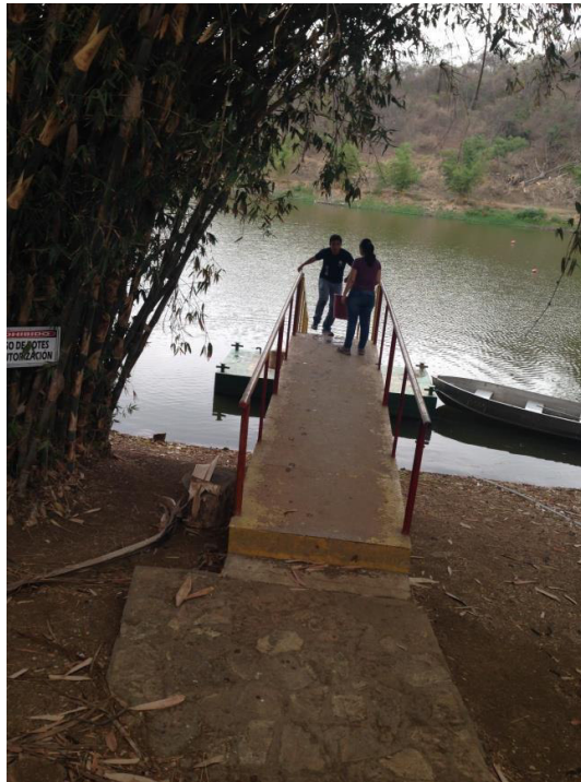
Toma de agua del lago de ESPOL para los tanques reservorios
