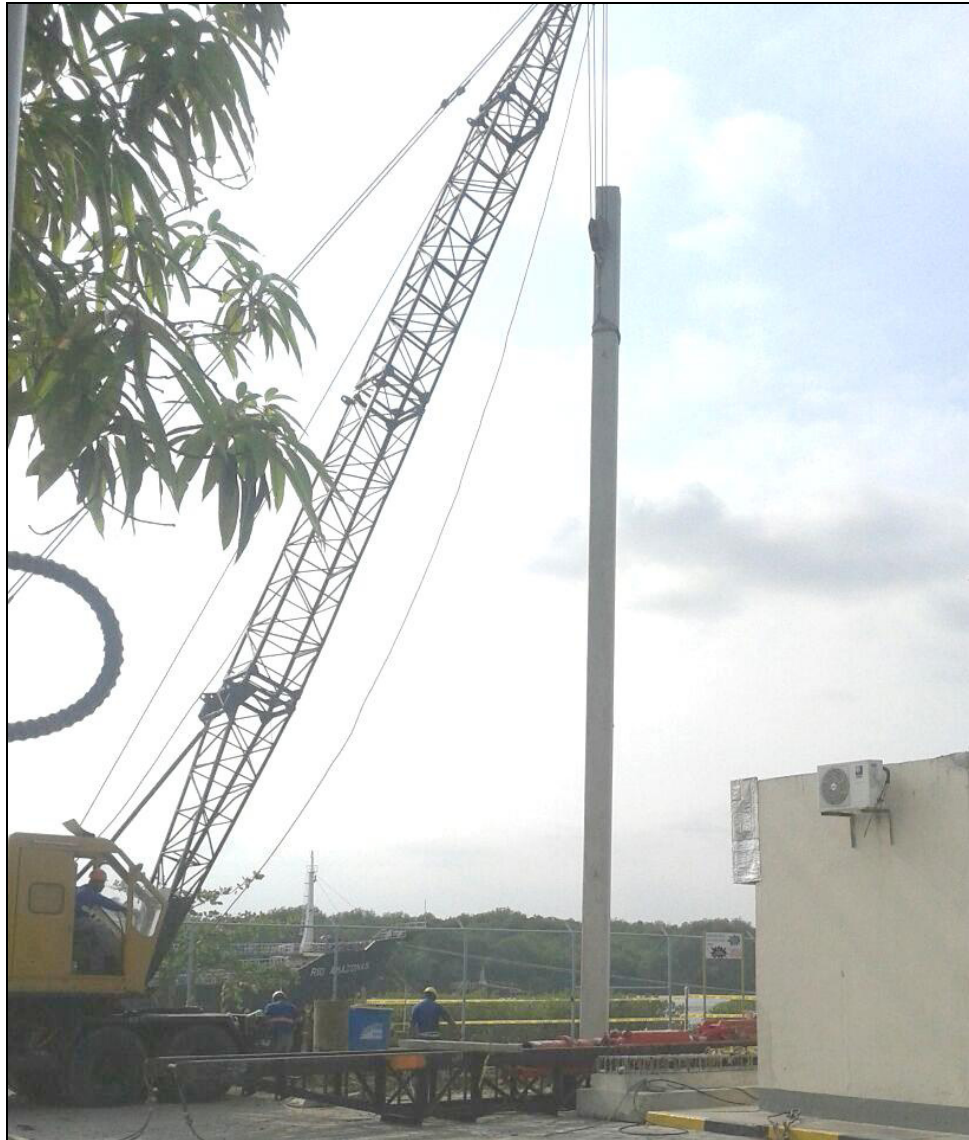
Figura 5.20. Izado del pilote.
