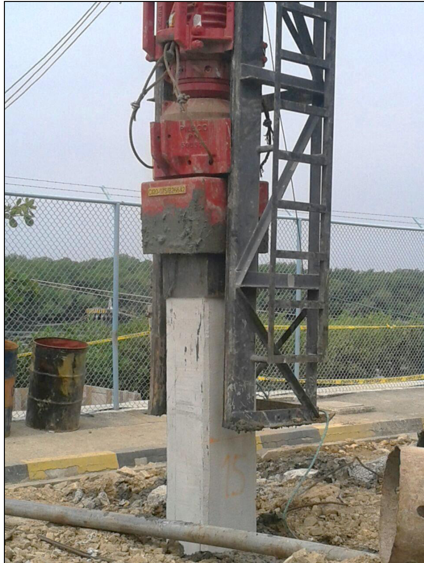
Figura 5.23. Martillo a diésel para hincado de pilotes.
