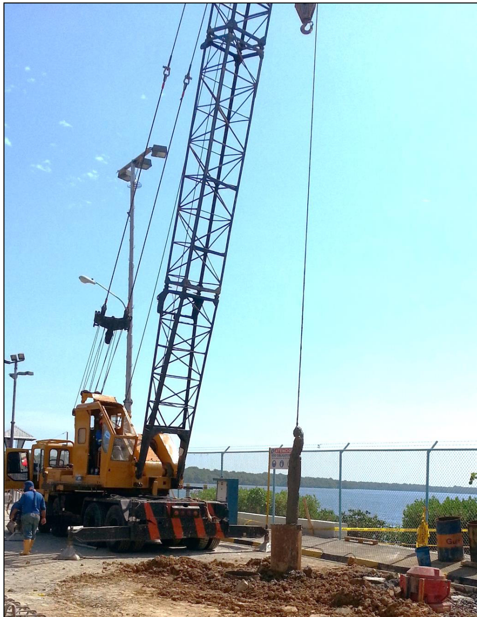
Figura 5.19. Perforación del agujero del pilote.
