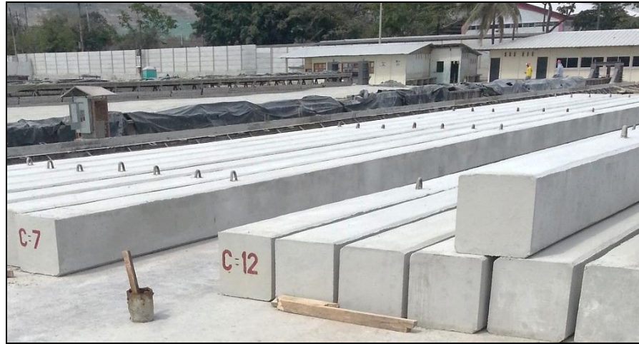
Figura 5.15. Pilotes prefabricados por la empresa Ditelme.
