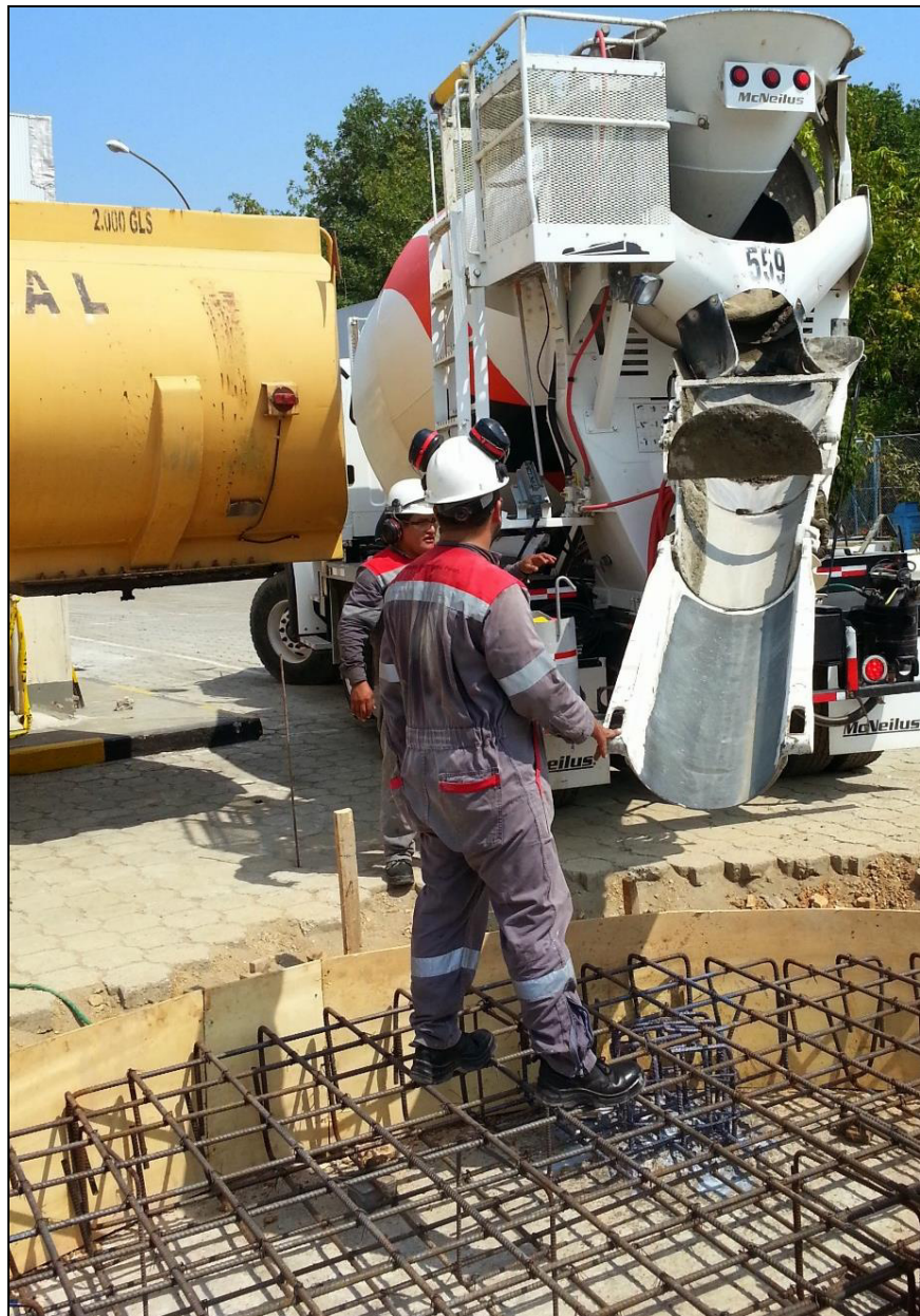
Figura 5.26. Mixer de Holcim Ecuador S.A. vaciando el hormigón directamente.
