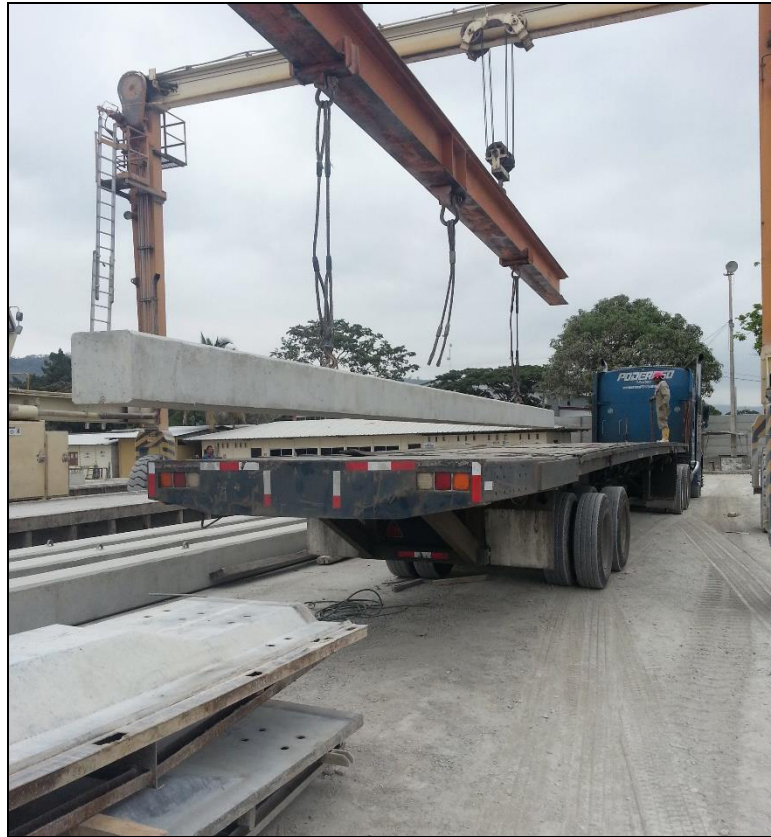
Figura 5.16. Plataforma de traslado de pilotes.
