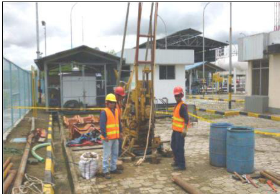
Figura 3.2. Equipos de perforación.
