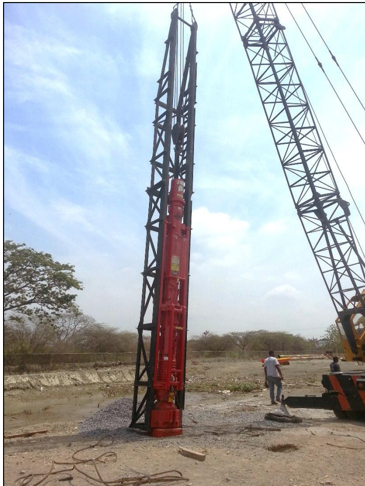
Figura 5.1. Martillo utilizado para hincar los pilotes de la cimentación del tanque de 12000 galones.
