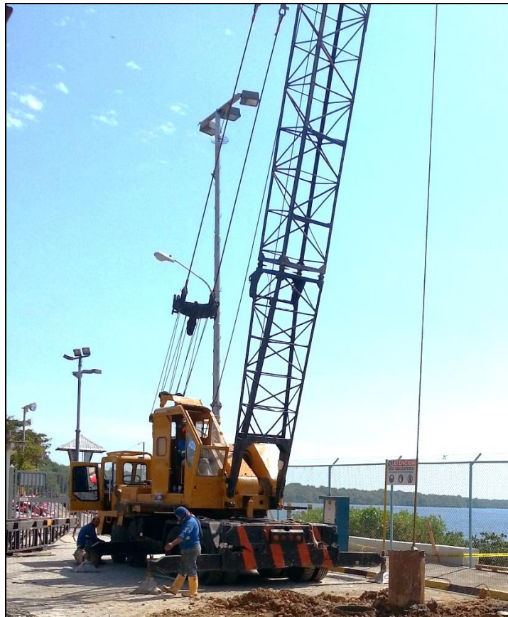
Figura 5.2. Grúa móvil utilizada para izar los pilotes y el martillo.
