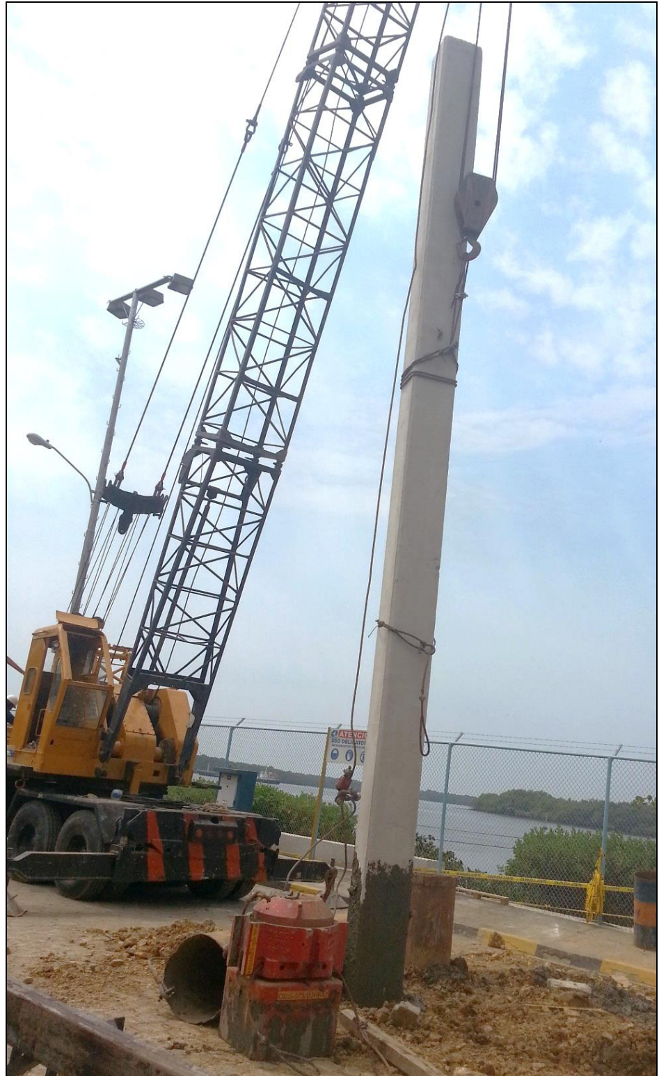
Figura 5.21. Colocación del pilote.
