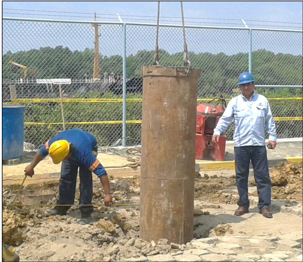
Figura 5.18. Fiscalizador en el proceso de colocación de la camisa recuperable.
