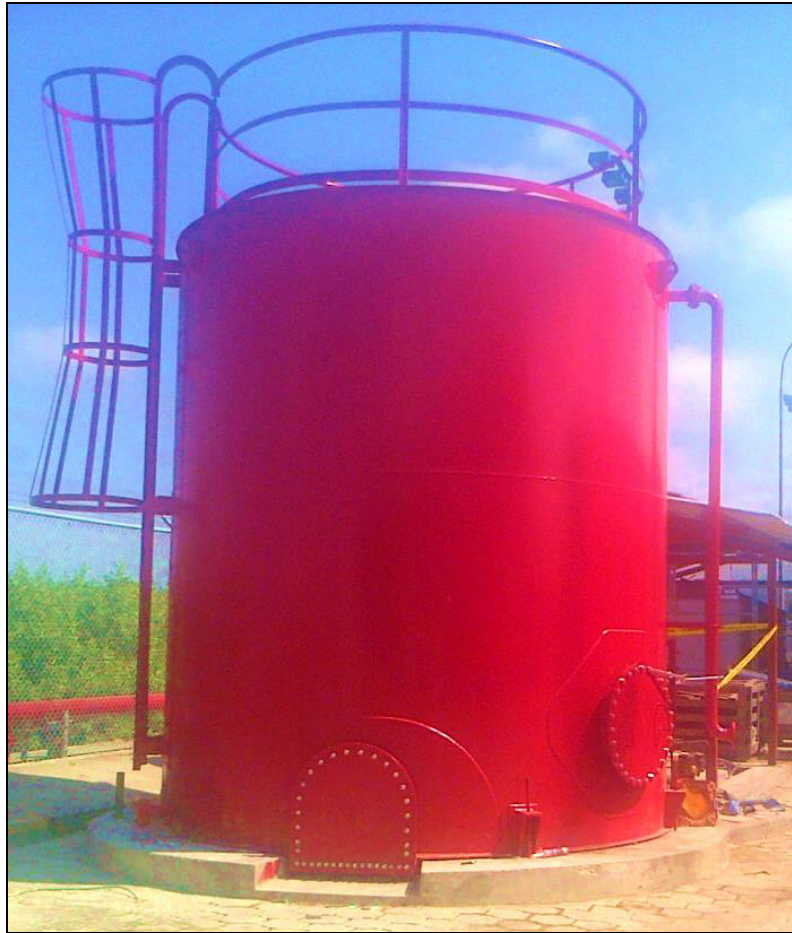
Figura 5.29. Tanque de 12000 galones sobre la cimentación construida.
