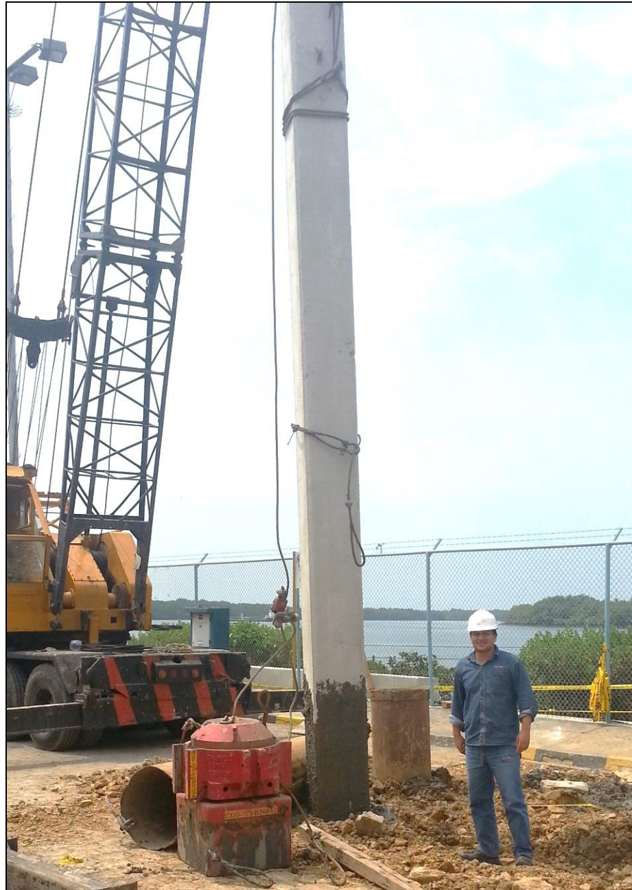
Figura 5.22. Yo en el proceso de hincado de los pilotes.
