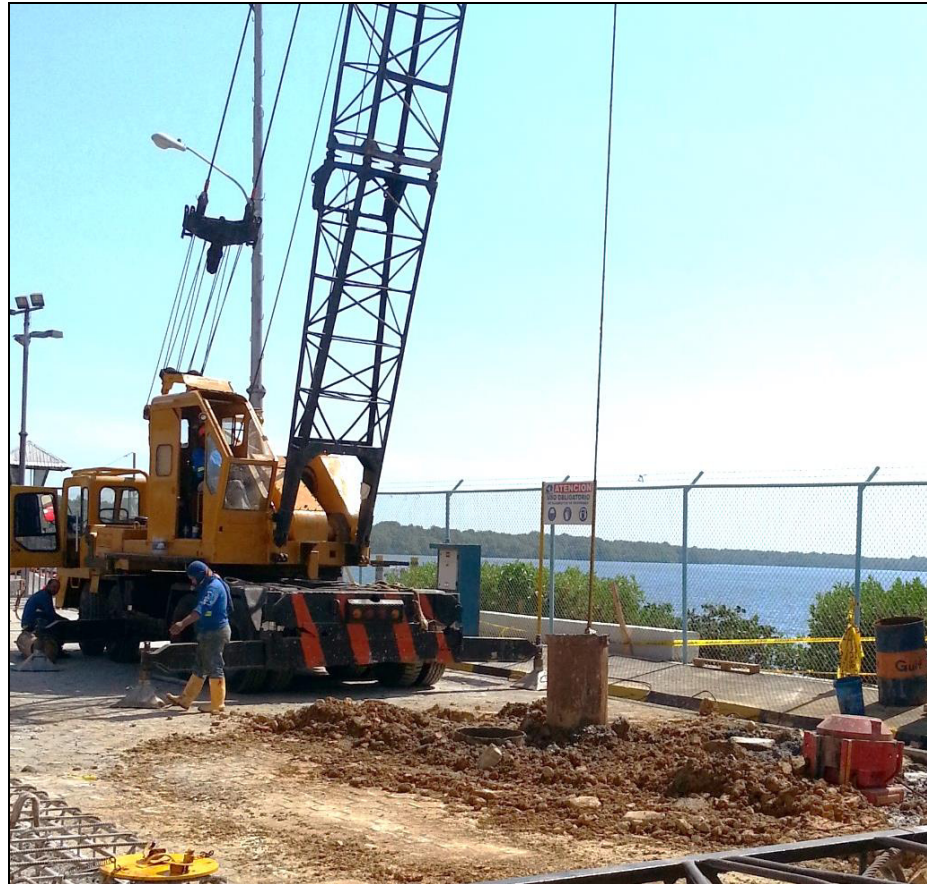
Figura 5.17. Colocación de la camisa recuperable.
