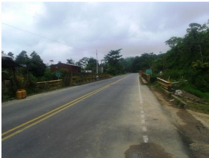
Foto # 17: Vista General Puente Río Daule
