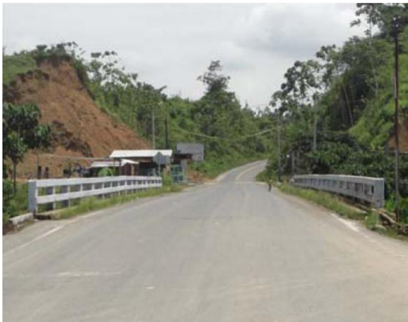
Foto # 26: Vista General Puente Río Repartidero
