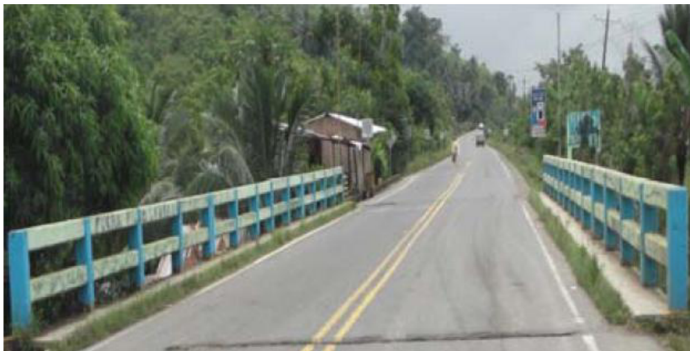
Foto # 13: Vista General Puente Río Aguas Claras
