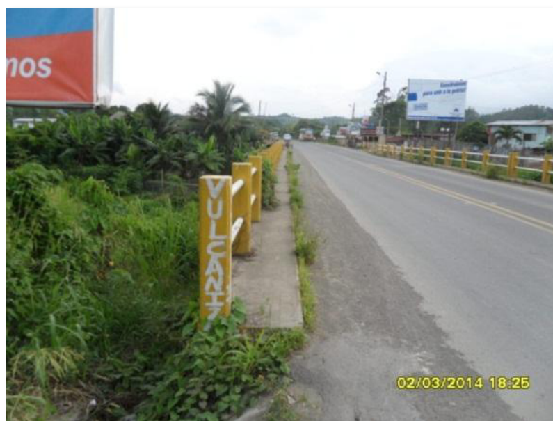
Foto # 10 Vista General Puente Río Tonchigüe
