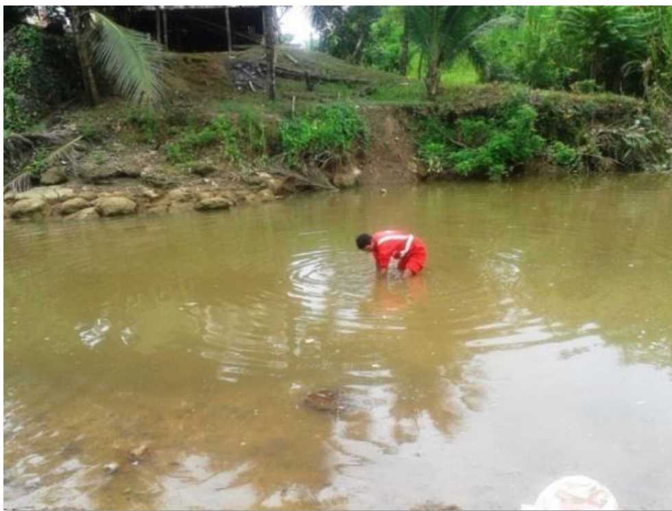
Foto # 14: Abundante vegetación y márgenes erosionados
