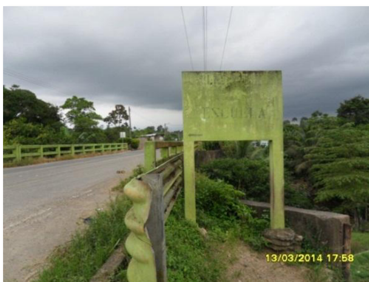
Foto # 2 Vista General Puente Río Bilsa
