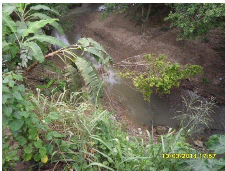
Foto # 4 Abundante vegetación y márgenes erosionados
