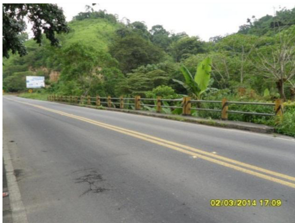
Foto # 6 Vista General Puente Río Guachal
