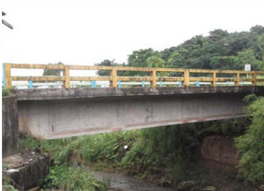
Foto # 22: Vista General Puente Río Maldonado
