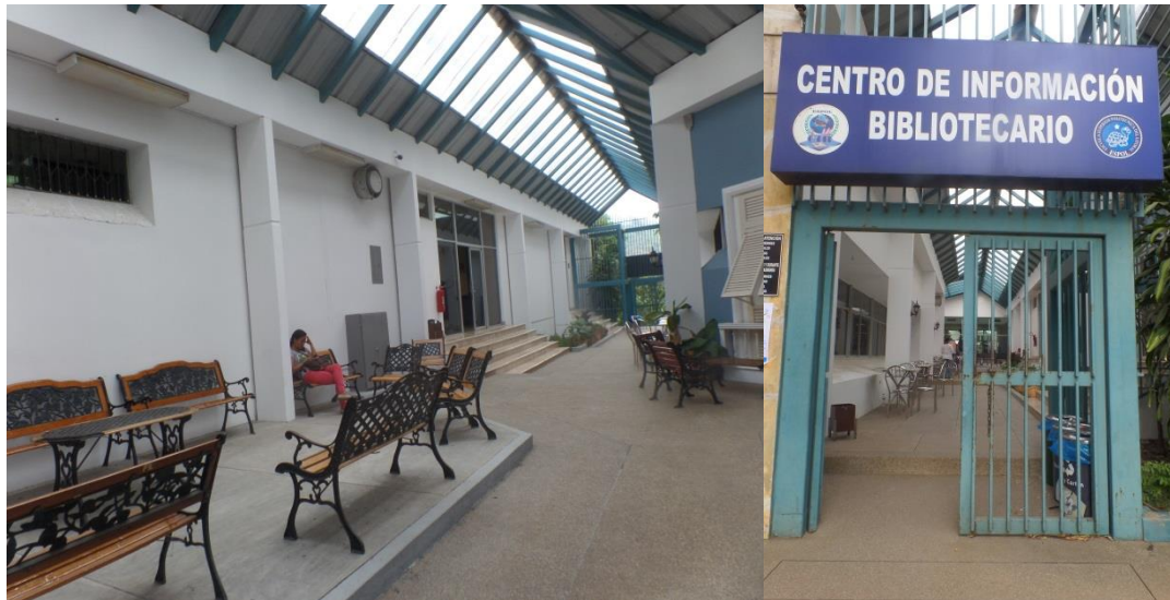
Ilustración 5. Área Exterior del CIB (Área 2)
