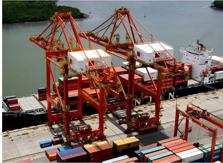
Ilustración 50. Grúa Quay crane (Fuente: Contecon)
