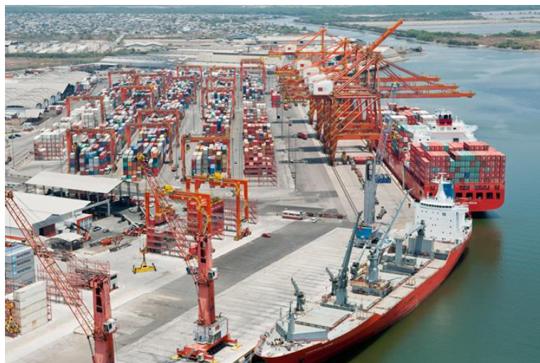
Ilustración 53. Vista general del Puerto de APG (Fuente: Contecon)
