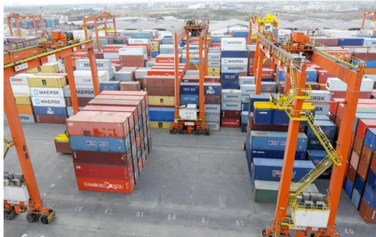
Ilustración 51. Grúa RTG (Fuente: Contecon)
