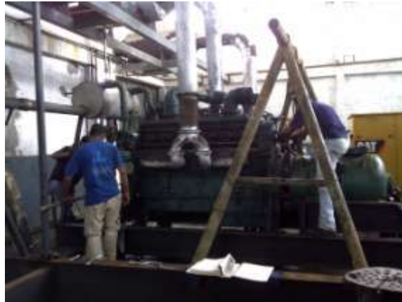
Figura 3.12 Mantenimiento Correctivo Generador.
