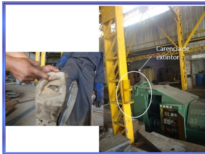
FIGURA 2.14: FALTA DE SEGURIDAD INDUSTRIAL
