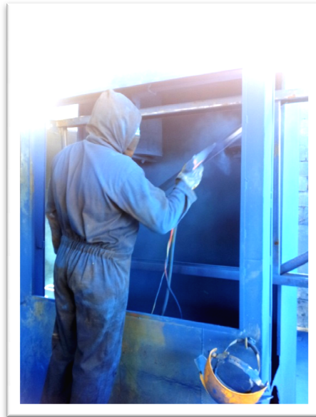
FIGURA 1.3 APLICACIÓN DE PINTURA Elaborado por: Christian Paredes, 2012
