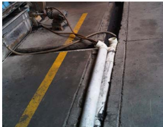
FIGURA 4.12 TUBERÍAS DESORDENADAS
