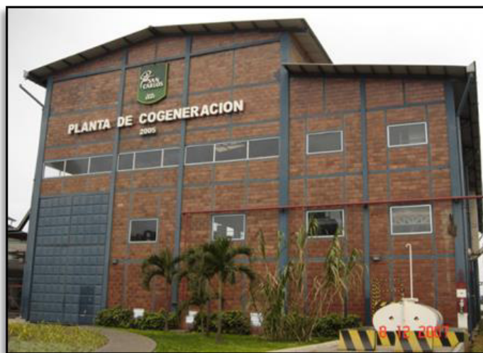
FIGURA 1.8. EDIFICIO DE COGENERACIÓN – INGENIO SAN CARLOS
