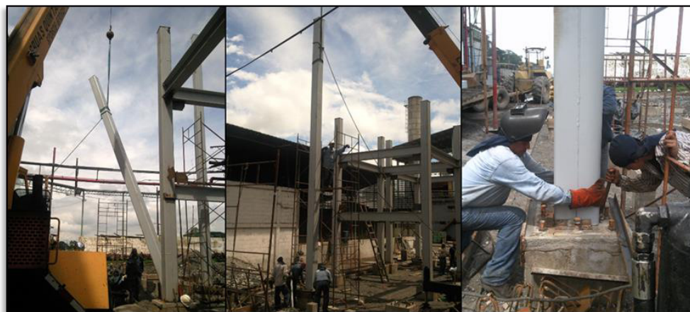
FIGURA 4.21. MONTAJE DE COLUMNAS.
