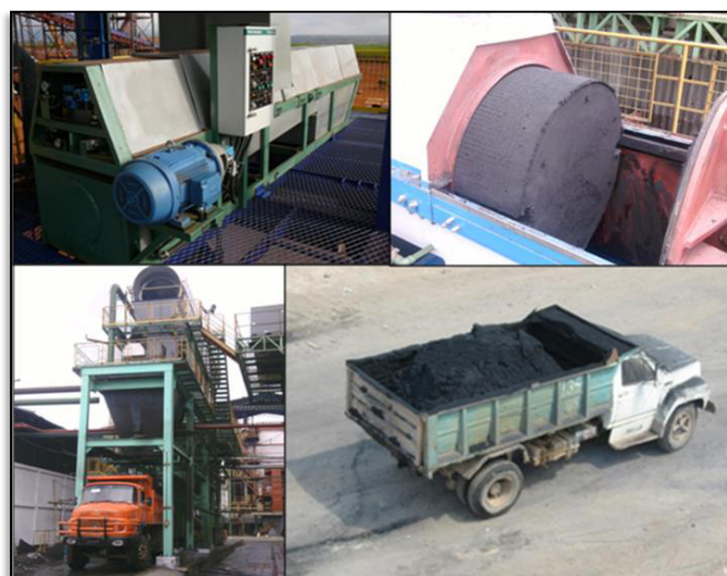
FIGURA 4.6. PRENSA DESAGUADORA Y PROCESO DE TRANSPORTE DE LA CENIZA
