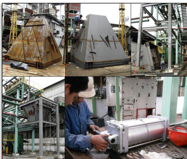
FIGURA 4.37. CONSTRUCCIÓN Y MONTAJE DE TOLVA PARA RECOLECCIÓN DE CENIZA.
