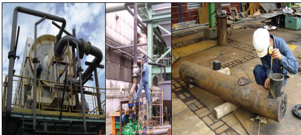
FIGURA 4.43. MONTAJE DE TUBERÍAS DE INTERCONEXIÓN – 2DA ETAPA.
