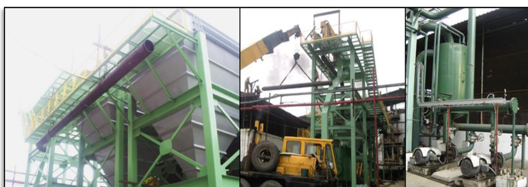
FIGURA 4.30. MONTAJE DE TUBERÍAS.
