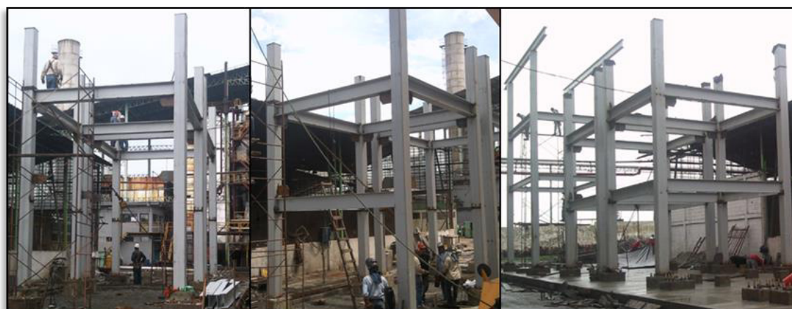
FIGURA 4.22. MONTAJE DE VIGAS DE AMARRE ENTRE COLUMNAS.
