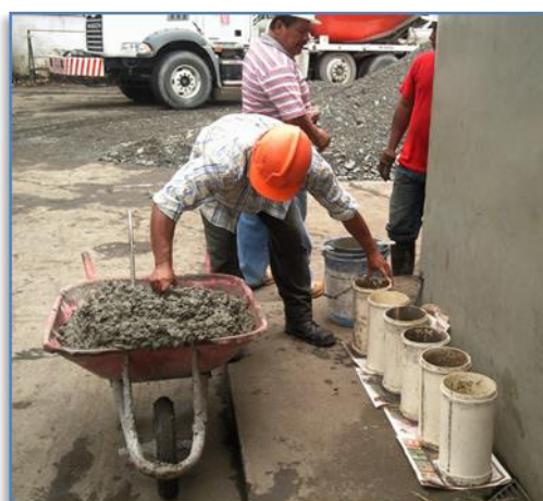
FIGURA 4.18. PREPARACIÓN DE CILINDROS DE HORMIGÓN.
