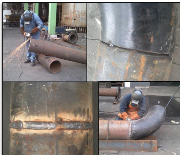
FIGURA 4.31. PROCESOS DE SOLDADURA DE LAS TUBERÍAS.
