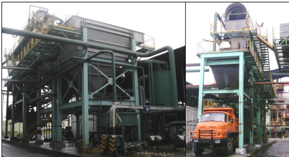
FIGURA 4.46. SISTEMA DE CLARIFICACIÓN DE AGUA CON CENIZA EN SU 2DA ETAPA.
