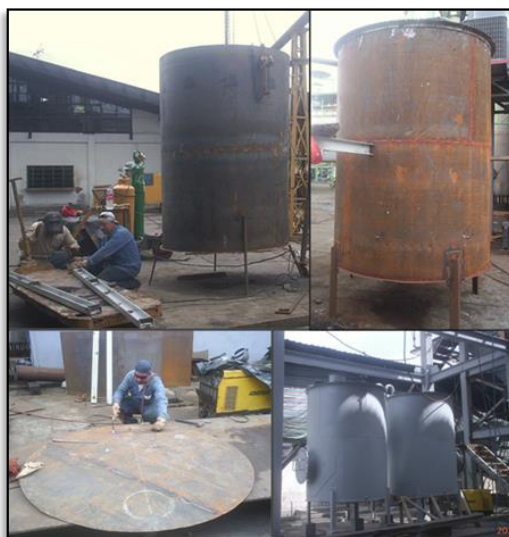
FIGURA 4.27. CONSTRUCCIÓN DE TANQUES DE FLOCULANTE.
