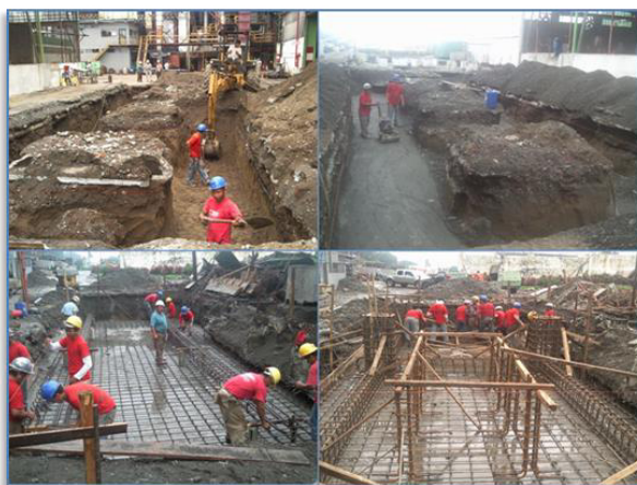
FIGURA 4.14. TRABAJOS DE EXCAVACIÓN, COMPACTACIÓN, ARMADO DE HIERROS Y ENCOFRADO.
