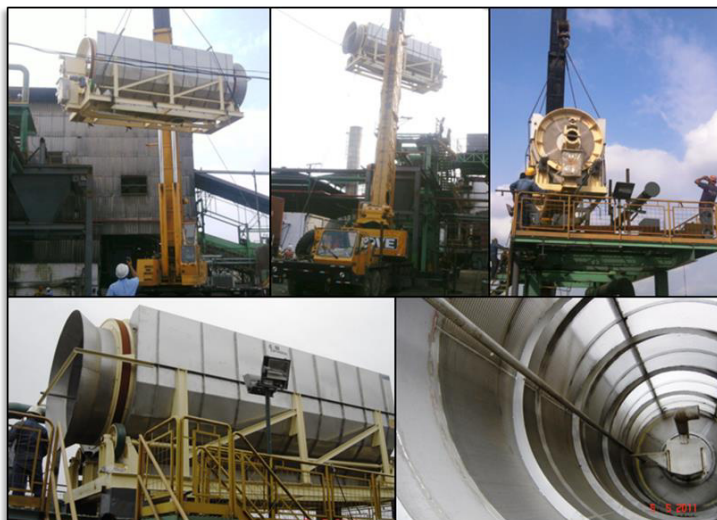
FIGURA 4.38. MONTAJE DE TAMIZ ROTATIVO.
