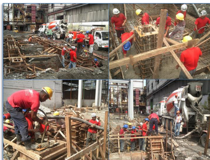
FIGURA 4.16. TRABAJOS DE VACIADO DE HORMIGÓN.
