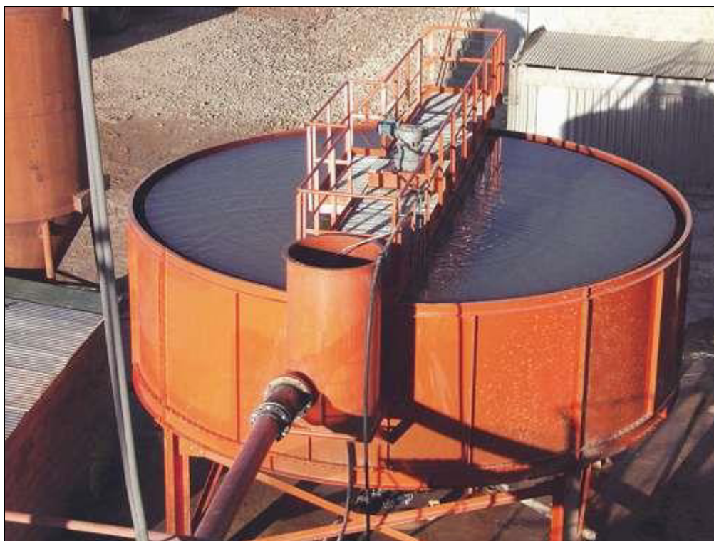
FIGURA 2.4. DECANTADOR DE CENIZA TIPO BANDEJA Y RASTRAS
