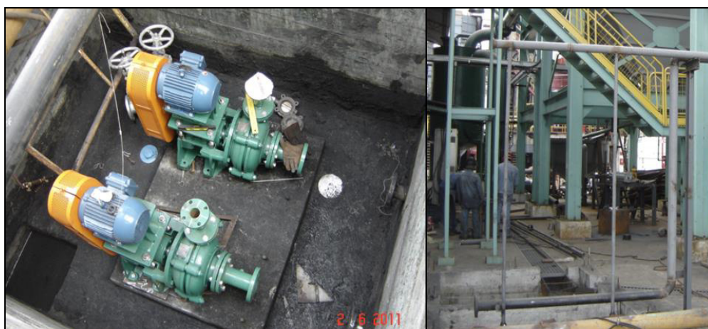
FIGURA 4.42. MONTAJE DE BOMBAS Y TUBERÍAS DEL TANQUE DE DRENOS.
