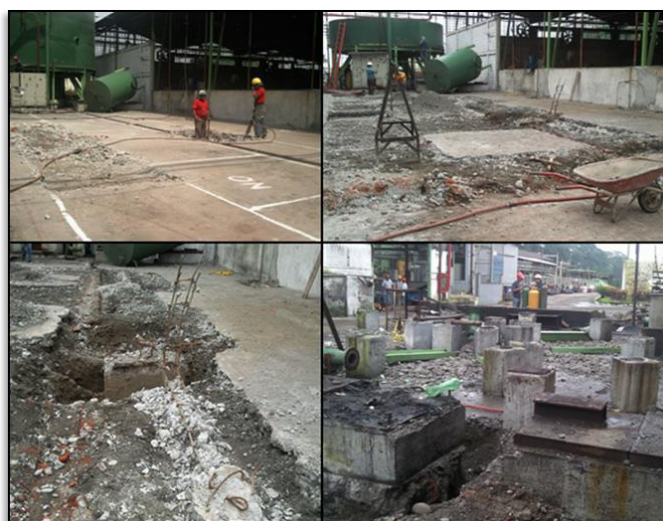
FIGURA 4.13. TRAZADO Y DEMOLICIONES PARA OBRA CIVIL
