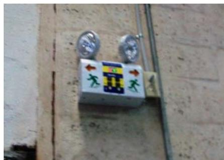
**FIGURA 3.21. LUCES DE EMERGENCIA DEL ÁREA DE EXTRUSIÓN DE FUNDAS**
