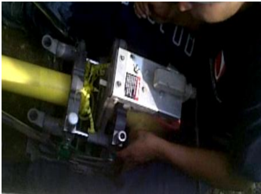
FIGURA 15 : REFRENTADO DE LA TUBERÍA DE POLIETILENO
