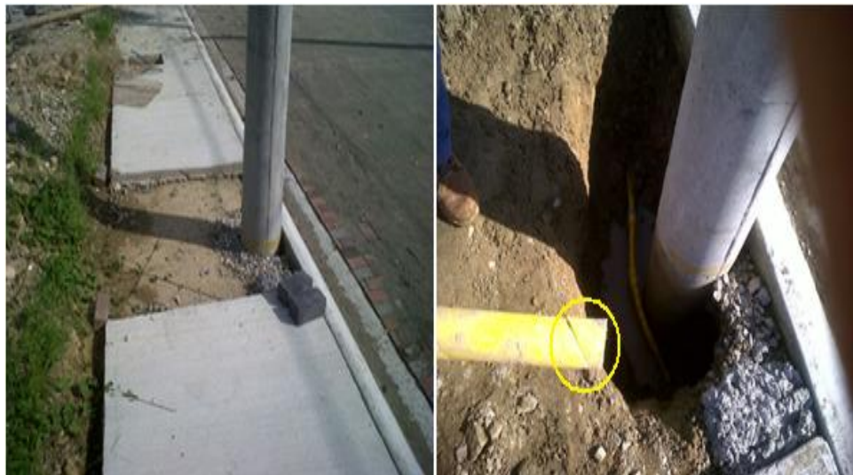
FIGURA 28: PERFORACIÓN DE LA TUBERÍA EN LA INSTALACIÓN DE UN POSTE DE ALUMBRADO PÚBLICO
