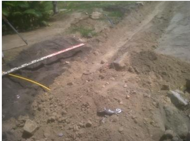
FIGURA 9: TUBERÍA ENTERRADA Y COMPACTADA
