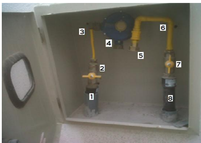
FIGURA 25: TREN DE REGULACIÓN DE SEGUNDA ETAPA
