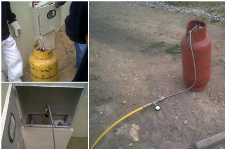
FIGURA 27: PRUEBA DE PRESIÓN REALIZADA POR LA INSTALADORA
