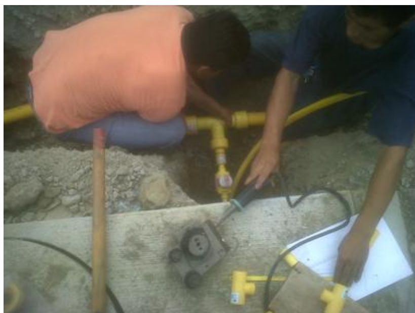
FIGURA 20: UNION DE LAS PIEZAS POR TERMOFUSIÓN CON MANGUITOS
