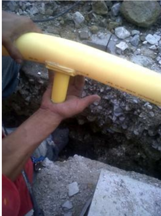
FIGURA 12 :INSTALACIÓN DE LA SILLETA EN LA TUBERÍA
