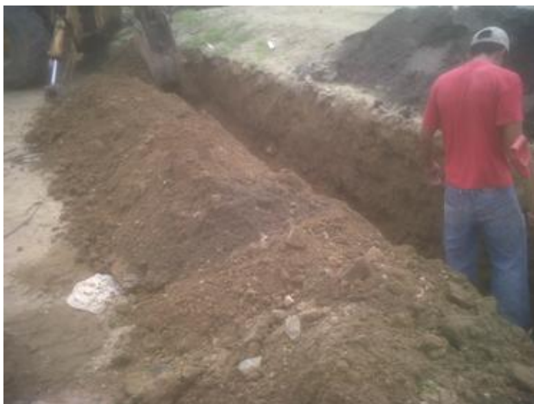
FIGURA 6:EXCAVACIÓN DE LA ZANJA
