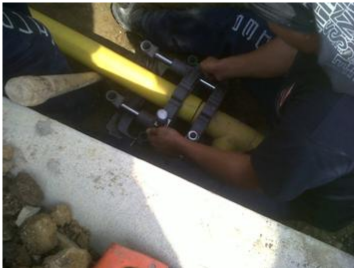
FIGURA 14 : ALINEACIÓN DE LOS TUBOS DE POLIETILENO EN EL CARRO GUÍA
