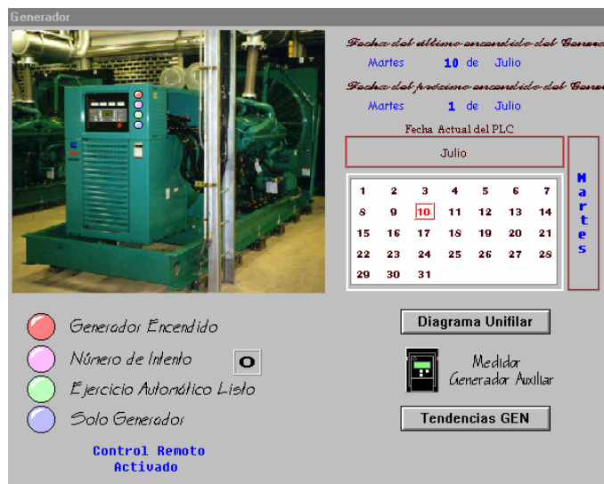
FIGURA 5.20. PANTALLA DE CONTROL DEL GENERADOR
