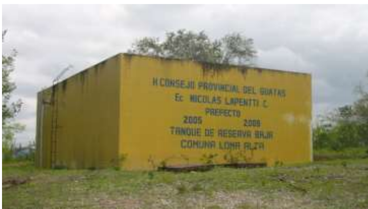
Reservorio de la Junta de agua “Loma Alta”, Loma Alta
