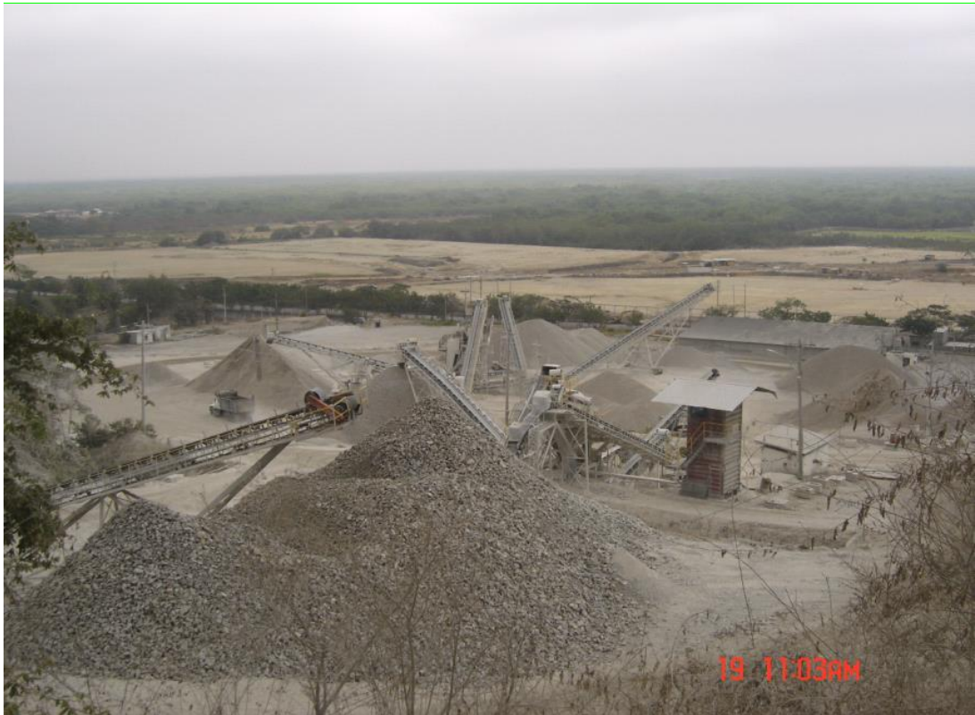
FIGURA 1.3.- Foto de la Planta Industrial de 350 TPH
