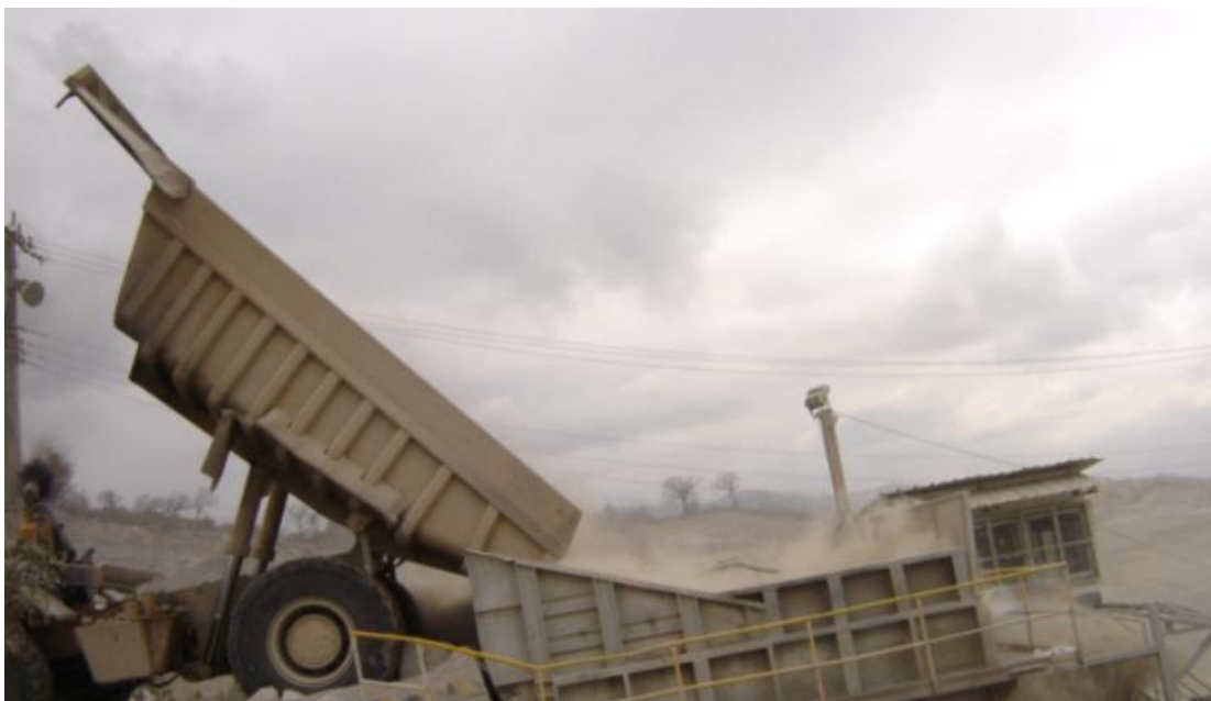
FIGURA 2.5.- Foto de dumper descargando material en tolva de recepción de primaria
