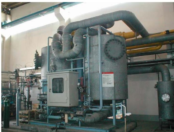
**FIGURA 2.7. TAMICES MOLECULARES DE PLANTA ASU**
