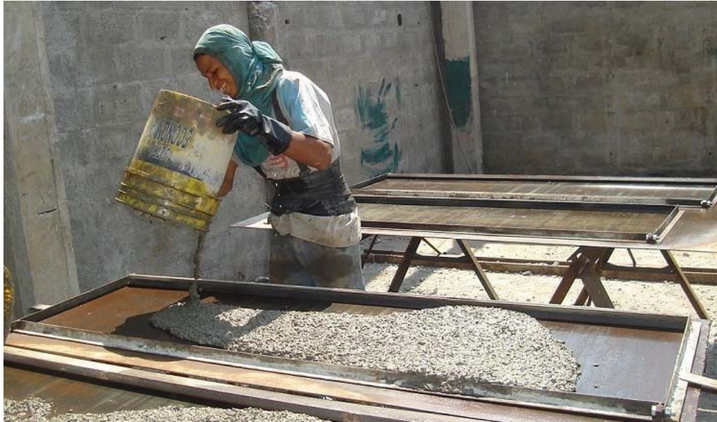
Figura 4.3. Operario provee de mezcla a molde
