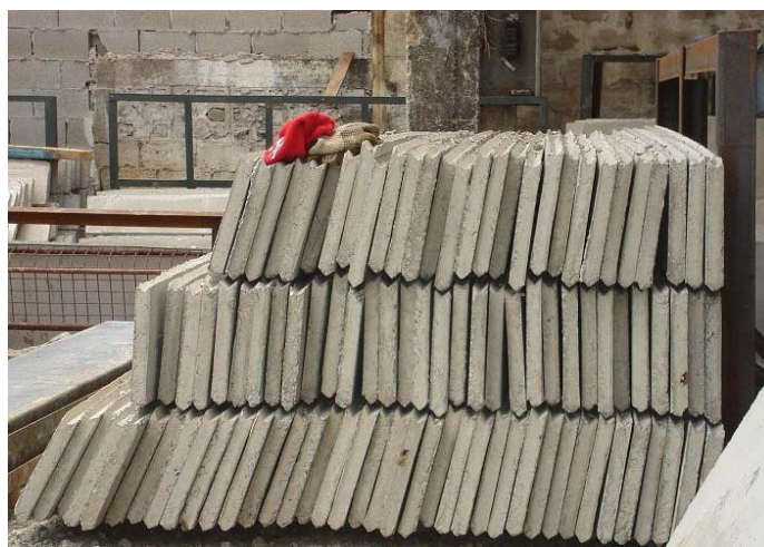
Figura 4.5. Vista lateral del almacenamiento de paneles encastre en V
