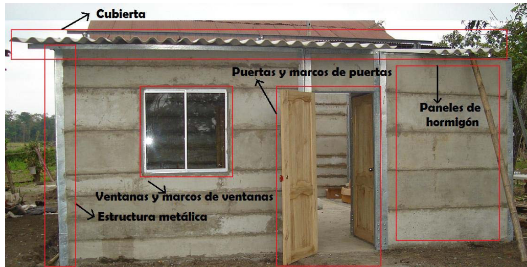
Figura 3.2. Casa prefabricada armada
