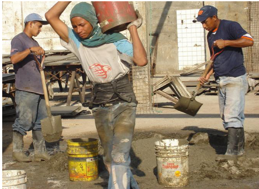
Figura 4.10. Mezclado manual
