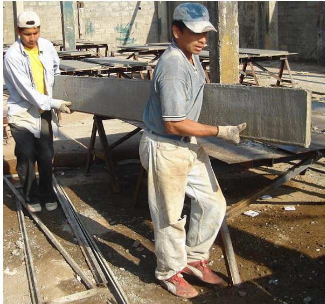
Figura 4.16. Transporte manual de paneles de hormigón
