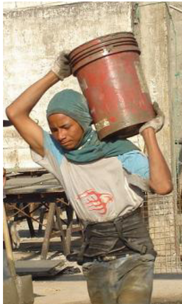
Figura 4.14. Carga de balde sugerido para mezcla
