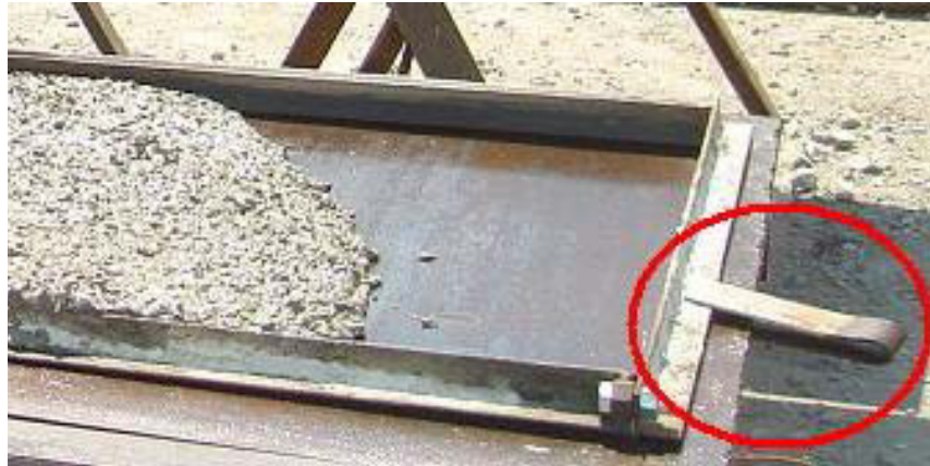
Figura 4.15. Binchas de agarre para fijar marcos y base de moldes
