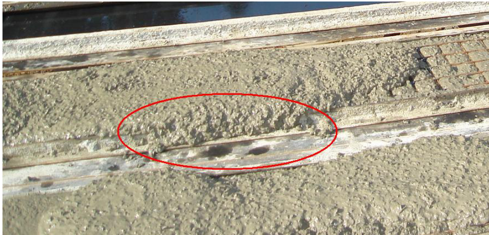
Figura 4.2. Mezcla regada en los alrededores del molde
