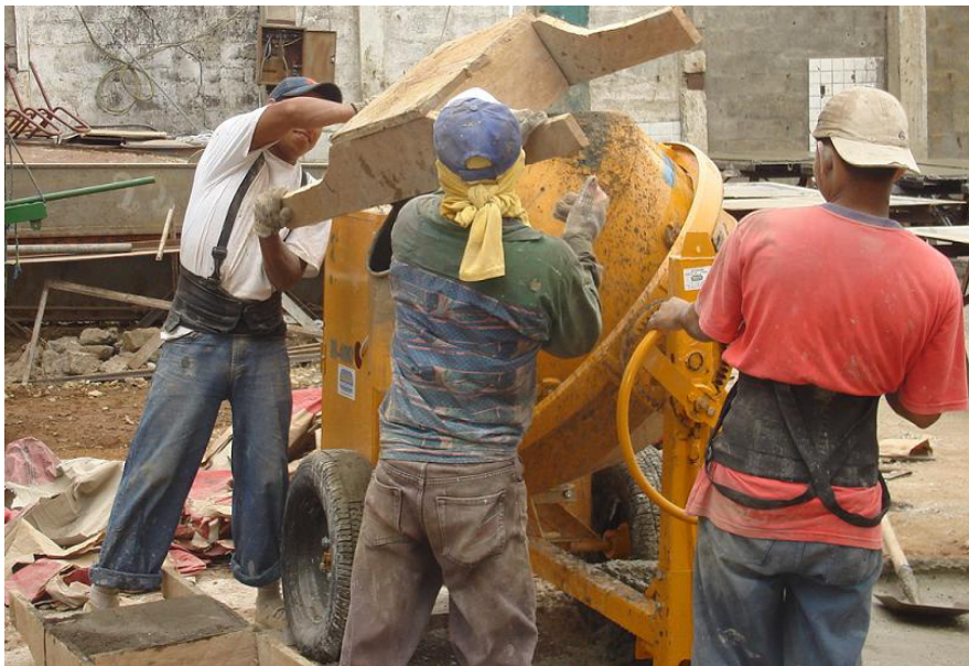
Figura 4.11. Mezclado asistido por máquina
