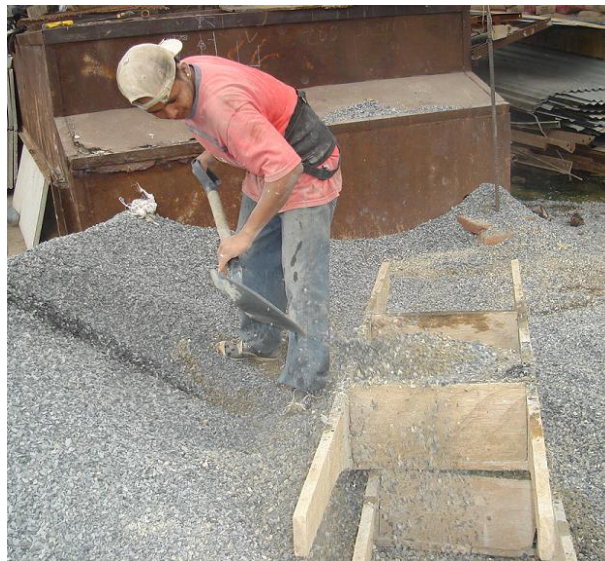
Figura 4.19. Operario paleando agregados
