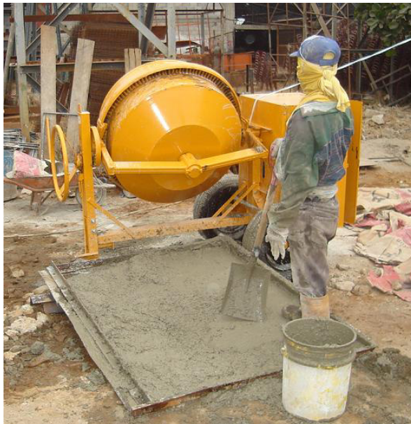
Figura 4.12. Área de descarga de mezcla
