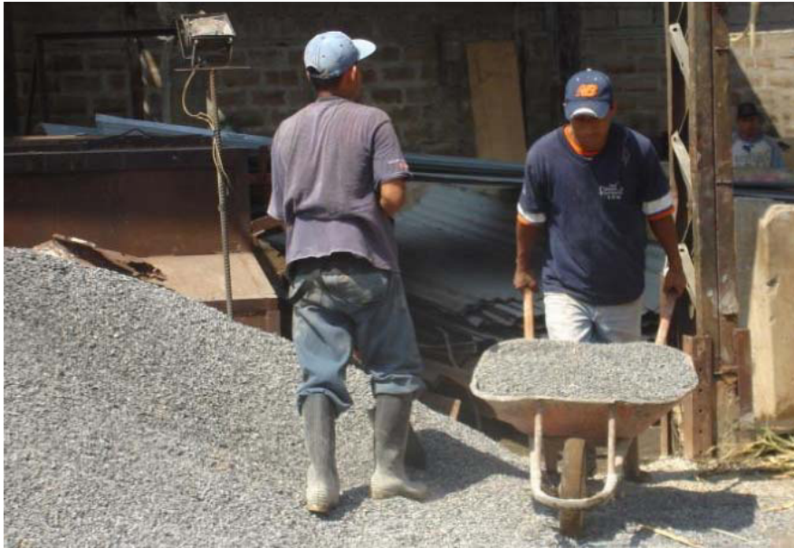
Figura 4.1. Operarios cargando agregados en carretilla
