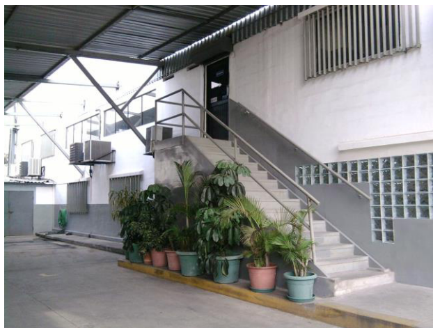
FIGURA 3.19. ESCALERA DEL ÁREA ADMINISTRATIVA
