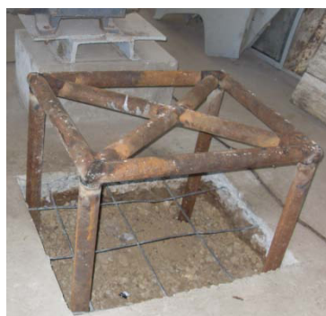
FIGURA 1.24. ARMADURA DE CIMENTACIÓN
