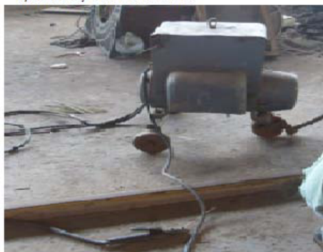
d) Soldadura Eléctrica
