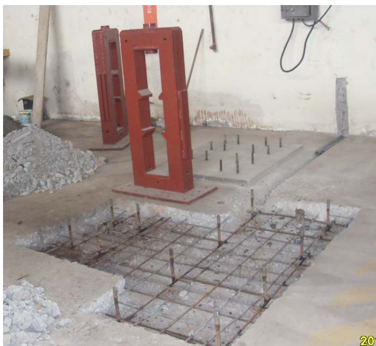
FIGURA 2.33. COLOCACION DE LOS PERNOS DE ANCLAJE
