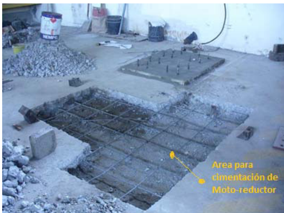
FIGURA 2.32. AREA PARA CONSTRUCCIÓN DE CIMENTACIÓN
