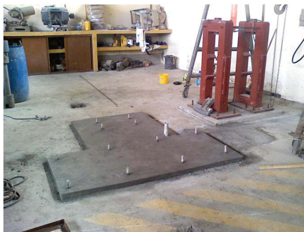
FIGURA 2.35. CIMENTACION DEL MOTO-REDUCTOR
