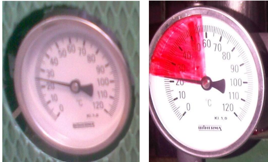
FIGURA 4.39. CONTROL VISUAL EN MANÓMETROS
