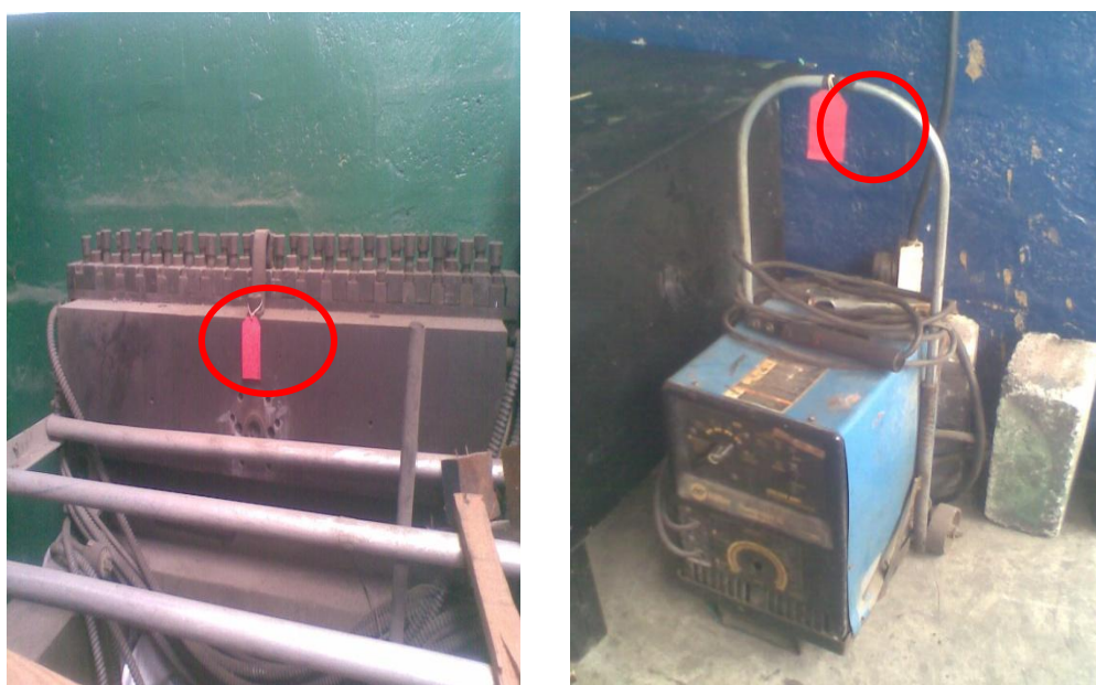
FIGURA 4.3. APLICACIÓN DE TÉCNICA DE TARJETAS ROJAS
