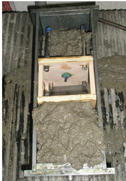
Fig. 11.- Molde en proceso de colado
