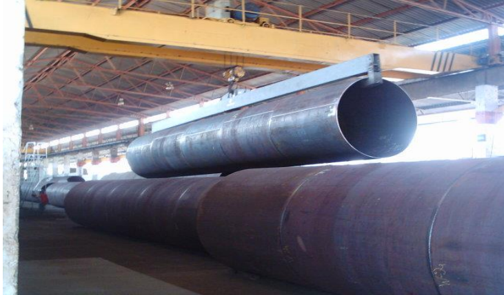
FIGURA 2.3 ARMADO DE TUBO
