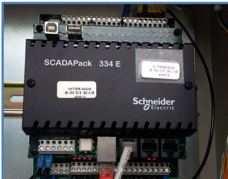
Figura 14.- Controlador SCADAPack 334 E
