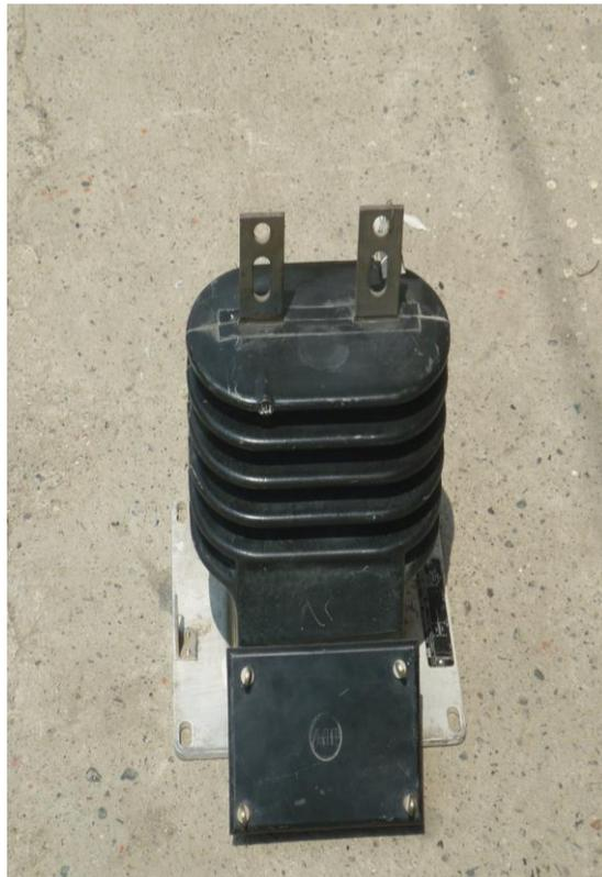
**Figura 7.- Transformador de Corriente**
