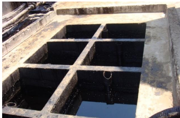
FIGURA 1.4. TRAMPAS DE DECANTACIÓN
