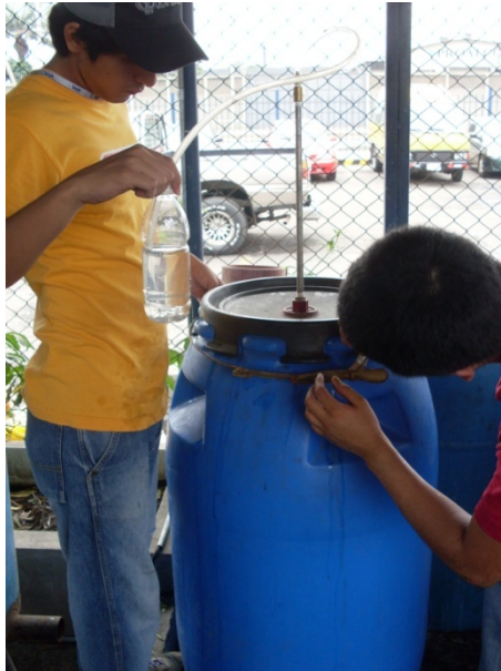
Figura #13. Cerrado hermético del tanque.
