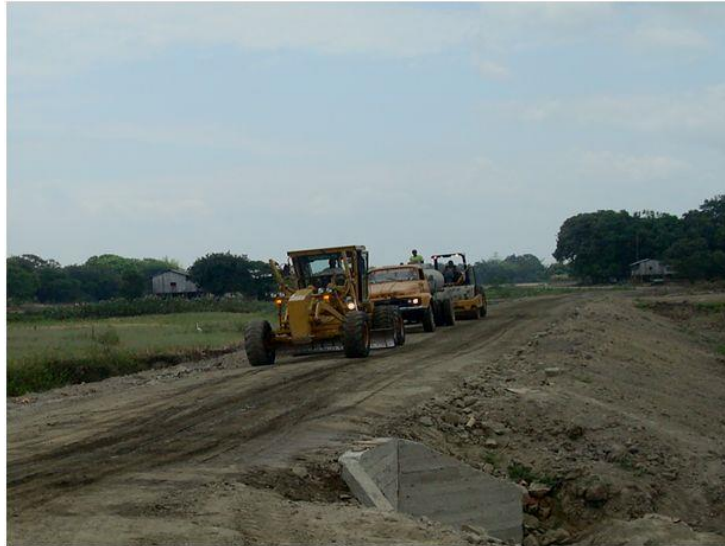
FIGURA 3.1 PROCESO COMPLETO DE CONSTRUCCIÓN
