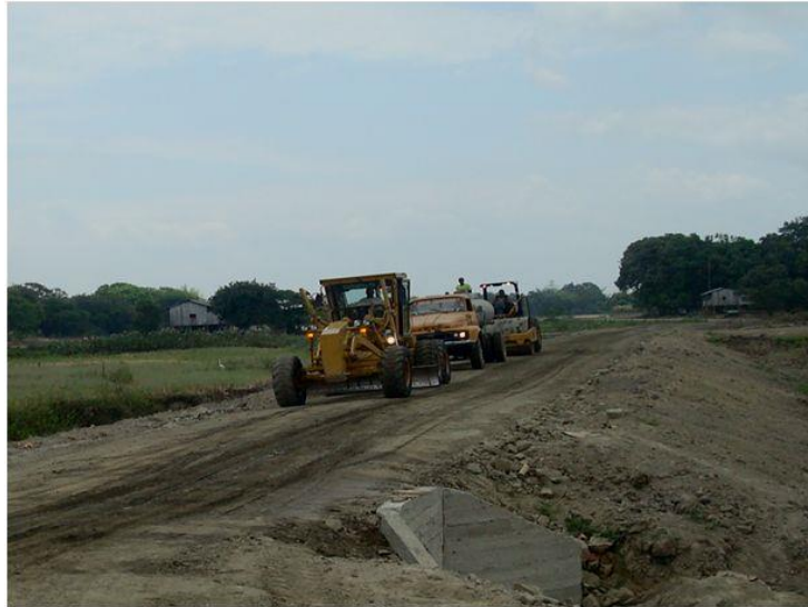
FIGURA 3.1 PROCESO COMPLETO DE CONSTRUCCIÓN
