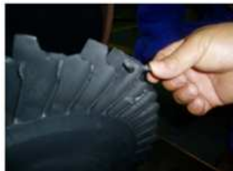
CORROSION POR ALTA TGE Y ALTA DEPOSICIÓN DE CARBÓN EN ALABES DE LAS TURBINAS
