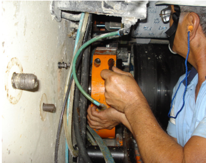
FIGURA 3.9 MECÁNICO AFLOJANDO LAS BRIDAS DE LOS RODAMIENTOS
