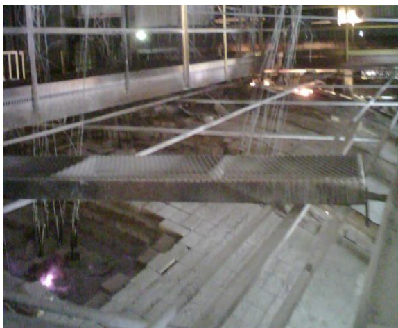
Fig. 3.1 Estado de la Corona del Horno Regenerativo
