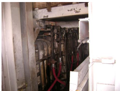
Fig. 3.13 Área de Quemadores (después)
