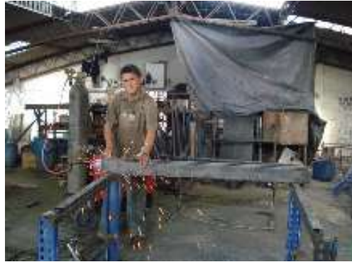
FIGURA 3.14 OPERACIÓN ENSAMBLE DE VIGAS
