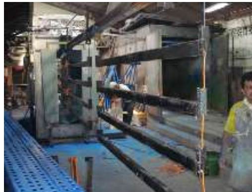
FIGURA 3.18 OPERACIÓN ROCIADO DE PINTURA A VIGAS
