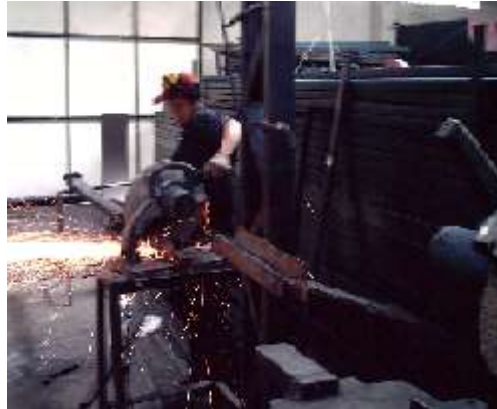
FIGURA 3.12 OPERACIÓN CORTE DE CANALES
