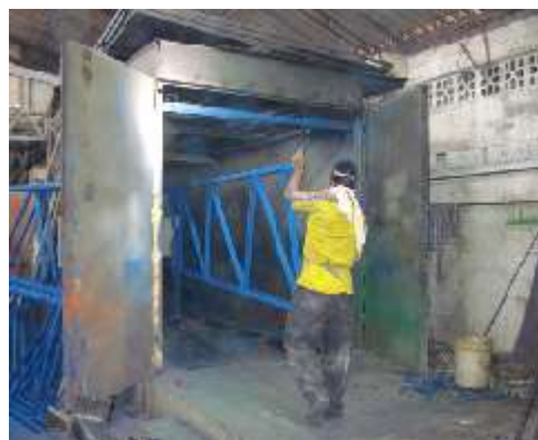
FIGURA 3.10 OPERACIÓN DE TRASLADO AL HORNO
