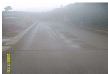
FIGURA 4.1 BÁSCULA CAMIONERA CON CAPACIDAD MÁXIMA DE 80 TONELADAS
