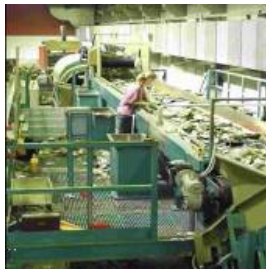
FIGURA 2.15 CINTA DE TRANSPORTACIÓN PARA CLASIFICACIÓN Y SEPARACIÓN
