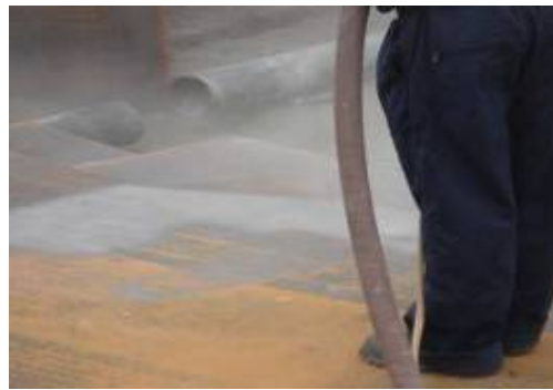
Figura 4.22 Chorro abrasivo con arena (FONDO)
