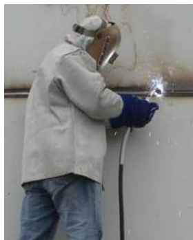
Figura 4.35(a) Soldadura circunferencial del cuerpo
