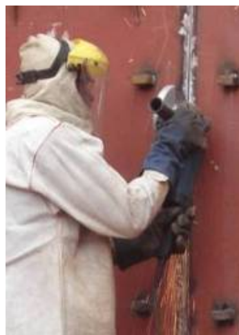
Figura 4.35(b) Limpieza soldadura vertical del cuerpo
