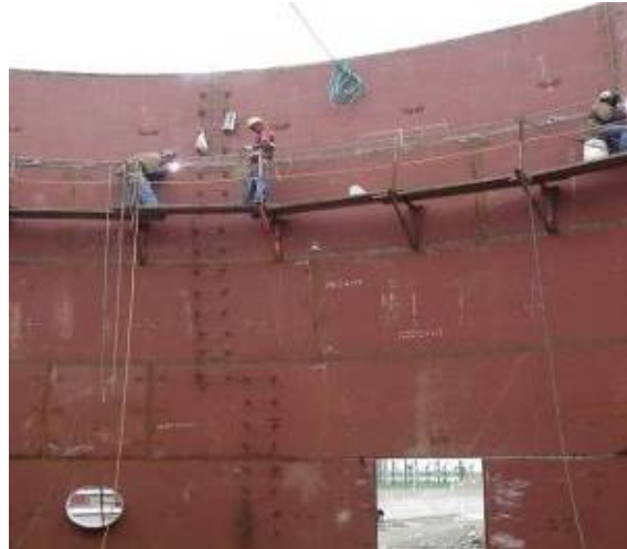
Figura 4.36 Soldadura del cuerpo.
