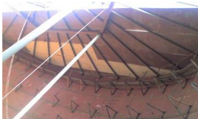
Figura 4.38 Montaje del techo
