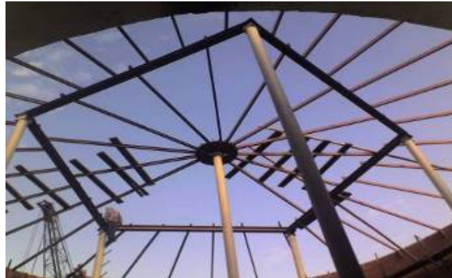
Figura 4.37 Montaje de la estructura
