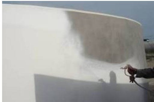
Figura 4.23 Primera capa de protección superficial
