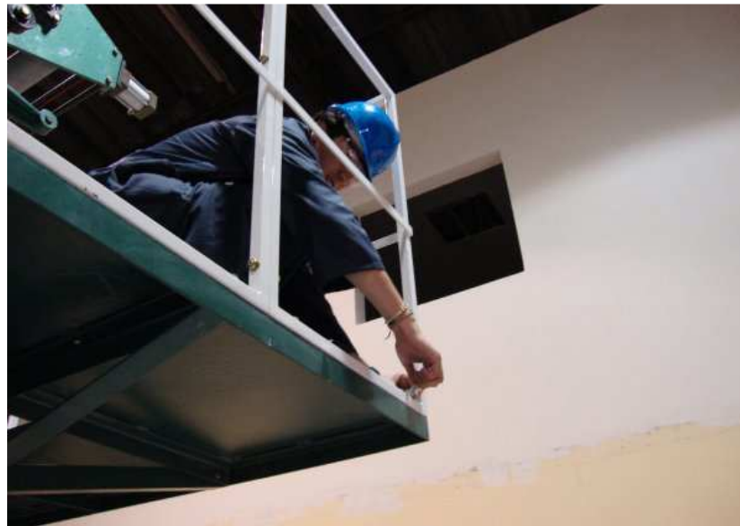
FIGURA 4.9 MONTAJE DE PASAMANOS EN PLATAFORMA Y ESCALERA.
