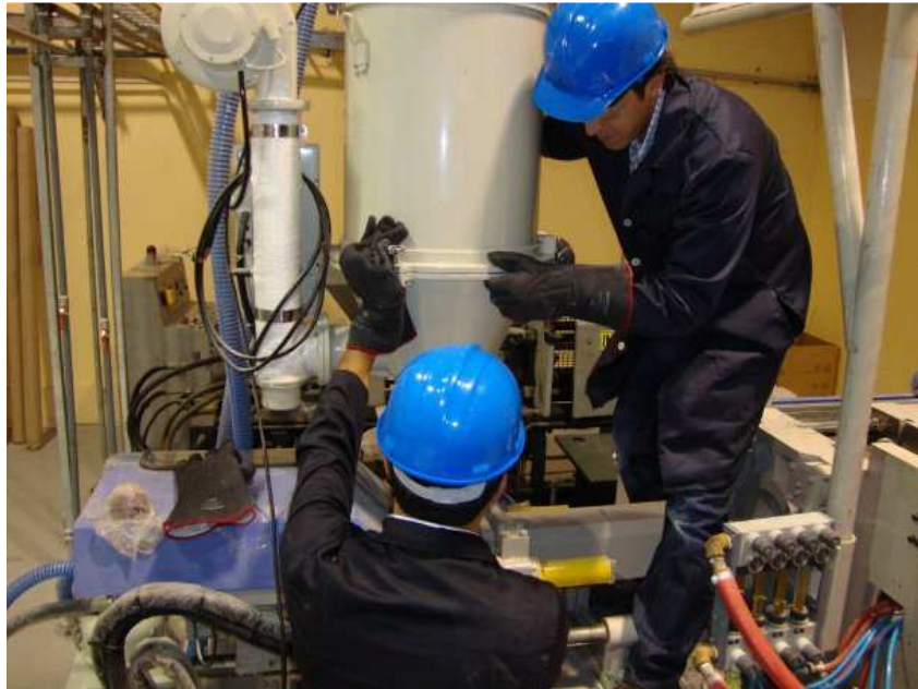
FIGURA 4.12 MONTAJE DE TOLVA DE SECADO.
