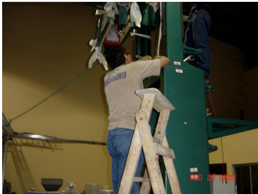
FIGURA 4.5 MONTAJE DE RODILLOS DE TIRO.
