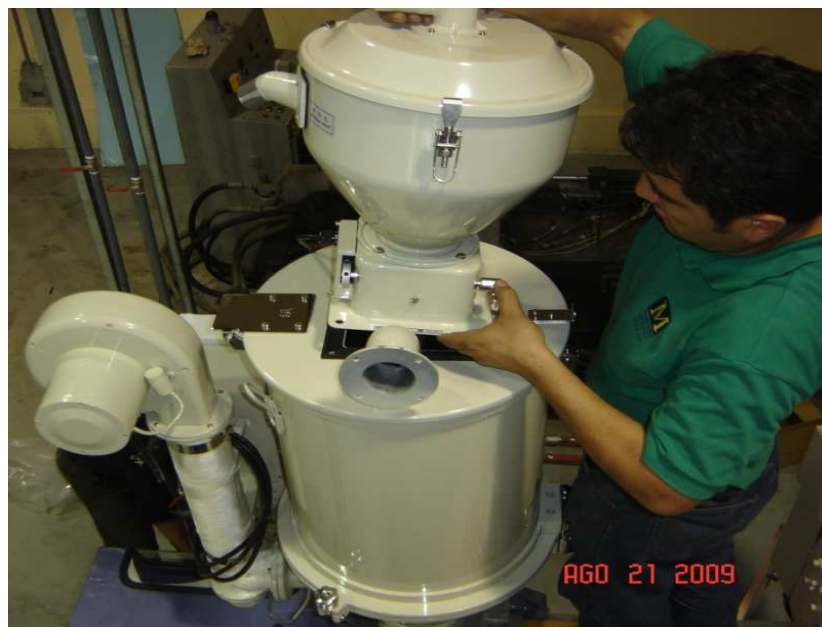
FIGURA 4.13 MONTAJE DE CARGADOR DE MATERIA PRIMA.
