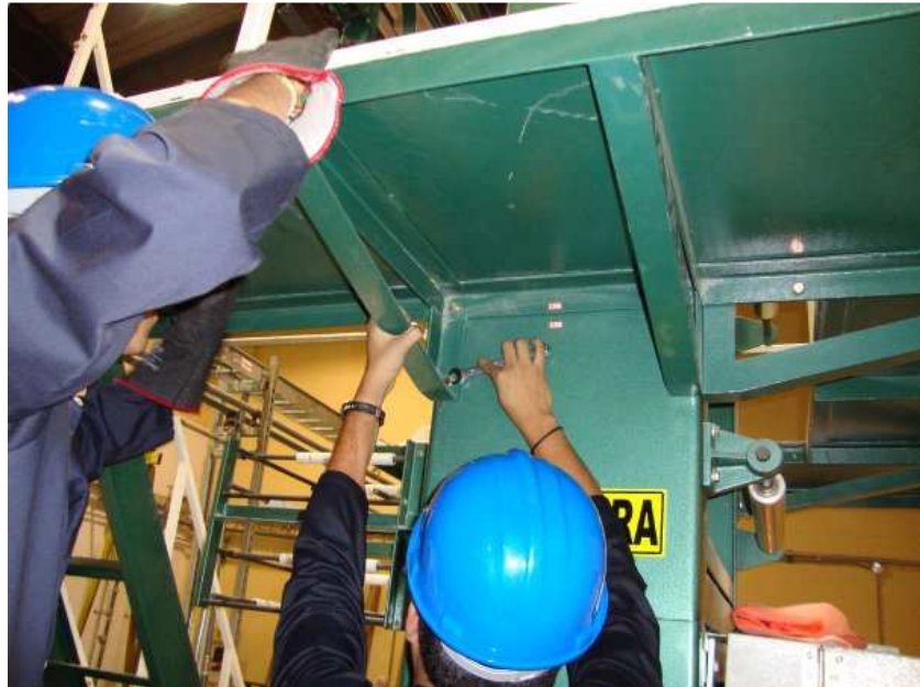
FIGURA 4.8 MONTAJE DE PLATAFORMA PARA OPERACIÓN.
