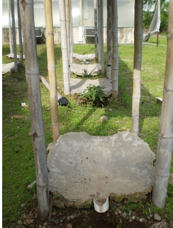
Estructuras de las camas de lixiviación
