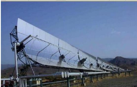
**Figura 16.** Colector solar de media concentración instalado en la plataforma de Almería
