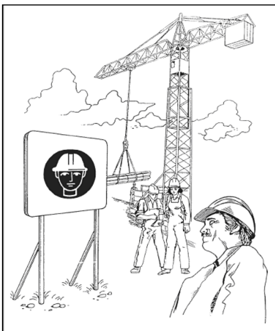
FIGURA 2.2: “ZONAS DE CASCOS” Fuente: Seguridad, salud y bienestar en las obras de construcción.
