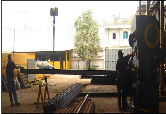
FIGURA 3.4 PRE-CURVADO DE VIGAS
