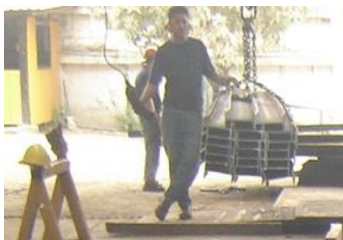
FIGURA 3.2 TRASLADO DE LAS VIGAS
