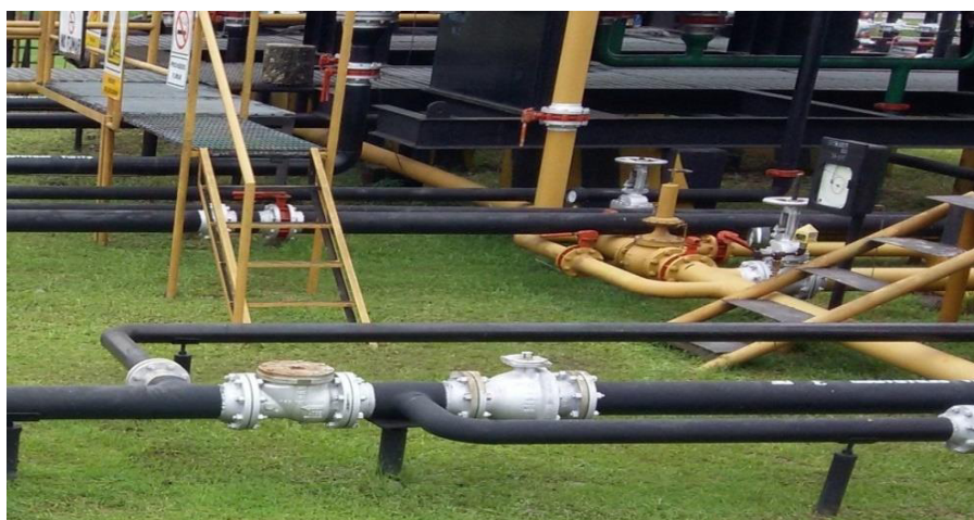
Figura 4.3 Válvulas reguladoras de control de flujo Fuente:
