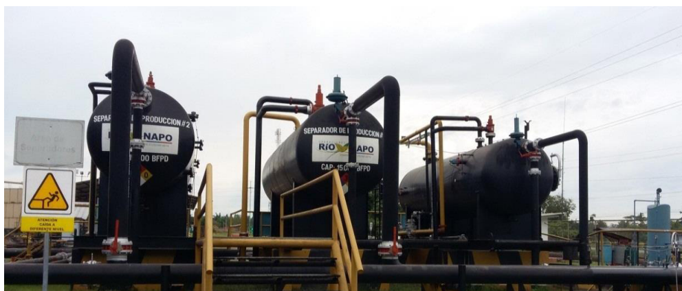
Figura 4.4 Válvulas de ingreso a los separadores Fuente:
