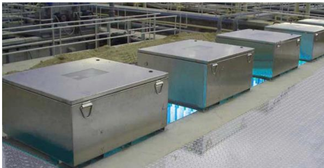
FIGURA 9. Sistema de desinfección ultravioleta.
