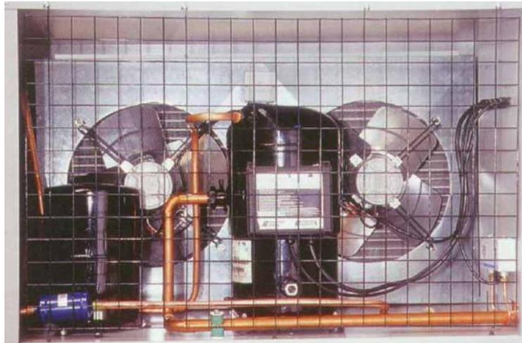
**Figura 3.9 Condensador.**
