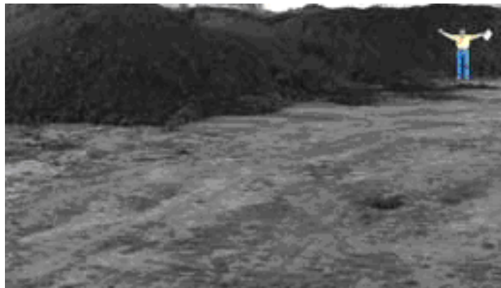
FIGURA 3.37. Extracción de lodos de las piscinas de oxigenación.
