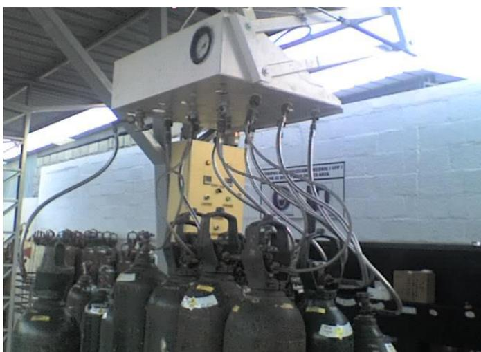
**FIGURA 3.10. CONEXIÓN DE CILINDROS CON EL RAK**
