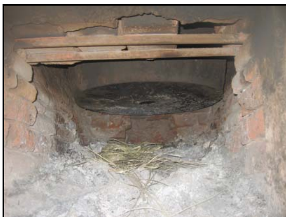
Figura 3.2. Cámara de combustión del Horno
