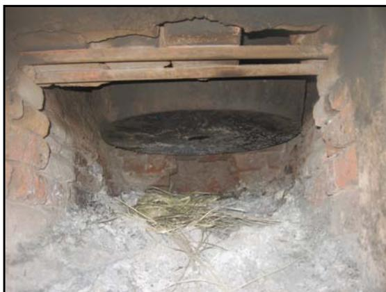
**Figura 3.2. Cámara de combustión del Horno**
